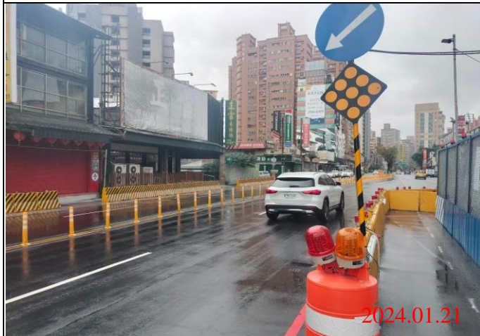
巡查日期地點：113.01.21/ Y21車站 照片說明：路面狀況
