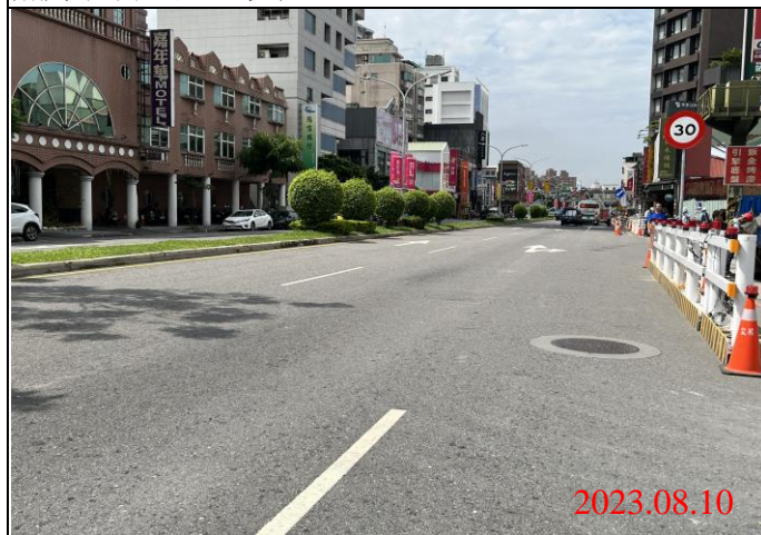
巡查日期地點：112.08.10/ Y21車站 照片說明：路面狀況
