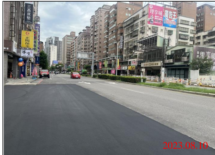
巡查日期地點：112.08.10/ Y22車站 照片說明：路面狀況
