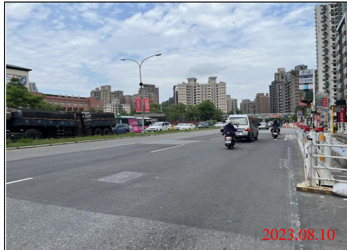
巡查日期地點：112.08.10/ Y23車站 照片說明：路面狀況
