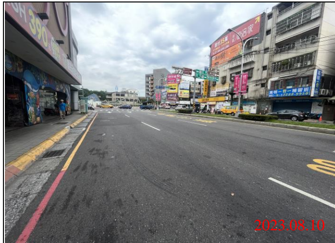
巡查日期地點：112.08.10/ Y21車站 照片說明：路面狀況
