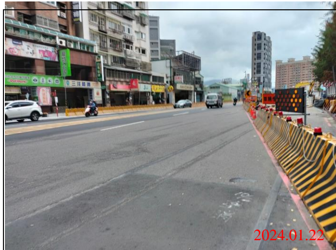
巡查日期地點：113.01.22/ Y22車站 照片說明：路面狀況
