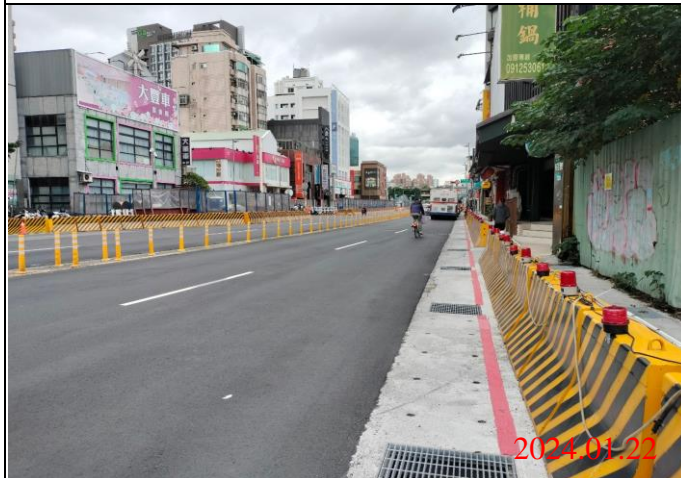
巡查日期地點：113.01.22/ Y21車站 照片說明：路面狀況
