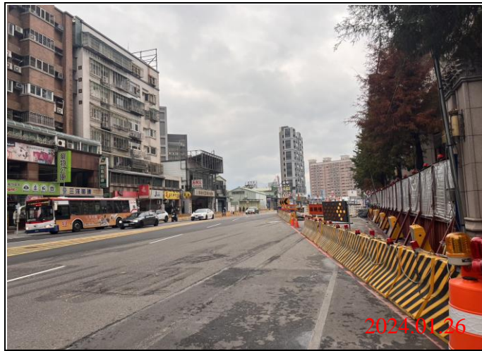
巡查日期地點：113.01.26/ Y22車站 照片說明：路面狀況
