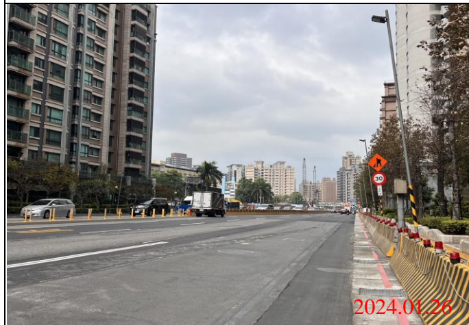
巡查日期地點：113.01.26/ Y23車站 照片說明：路面狀況
