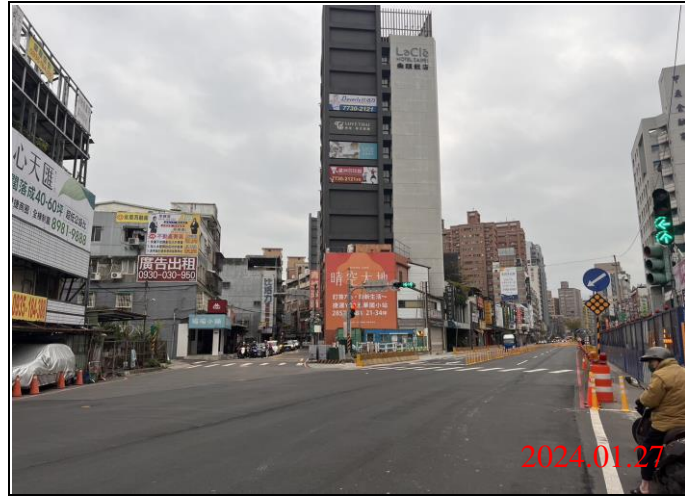
巡查日期地點：113.01.27/ Y21車站 照片說明：路面狀況
