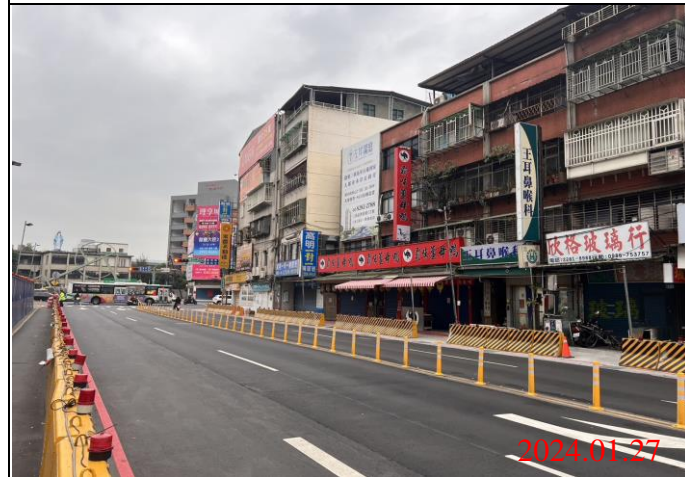
巡查日期地點：113.01.27/ Y21車站 照片說明：路面狀況
