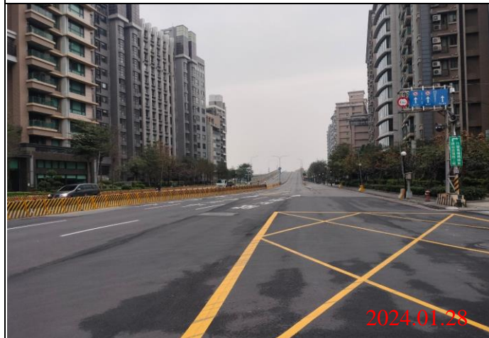
巡查日期地點：113.01.28/ Y23車站 照片說明：路面狀況
