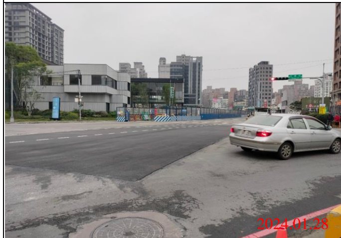
巡查日期地點：113.01.28/ Y22車站 照片說明：路面狀況
