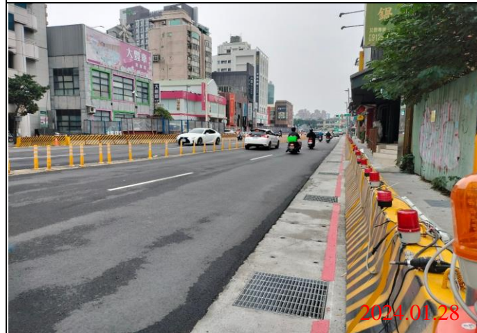
巡查日期地點：113.01.28/ Y21車站 照片說明：路面狀況
