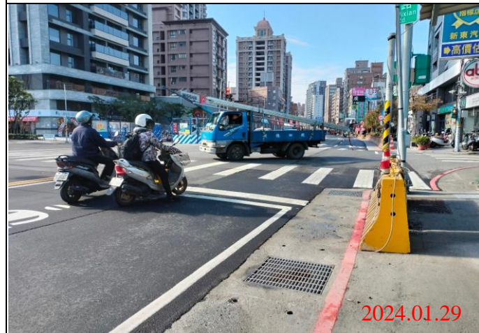
巡查日期地點：113.01.29/ Y22車站 照片說明：路面狀況
