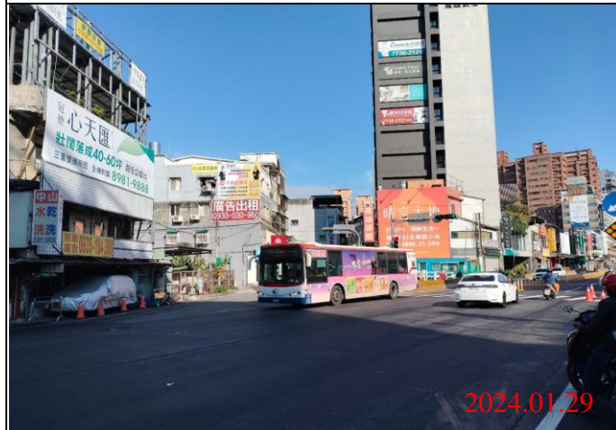
巡查日期地點：113.01.29/ Y21車站 照片說明：路面狀況
