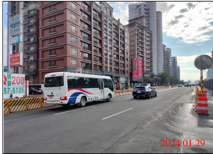
巡查日期地點：113.01.29/ Y23車站 照片說明：路面狀況
