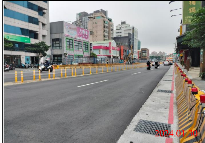
巡查日期地點：113.01.30/ Y21車站 照片說明：路面狀況
