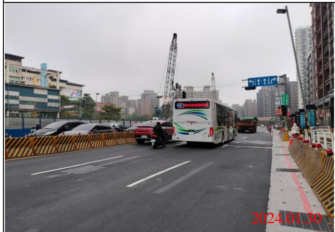
巡查日期地點：113.01.30/ Y23車站 照片說明：路面狀況
