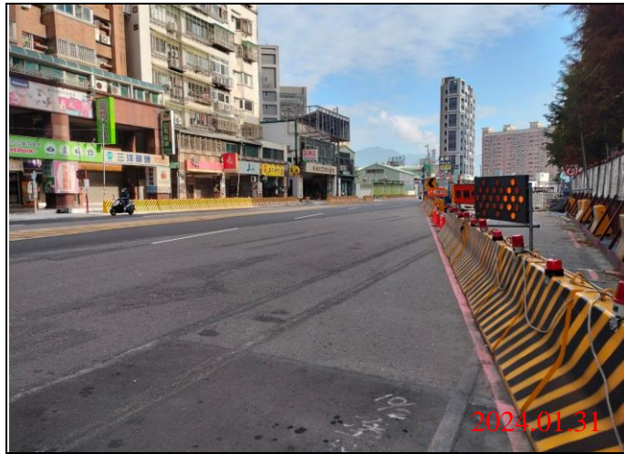
巡查日期地點：113.01.31/ Y22車站 照片說明：路面狀況
