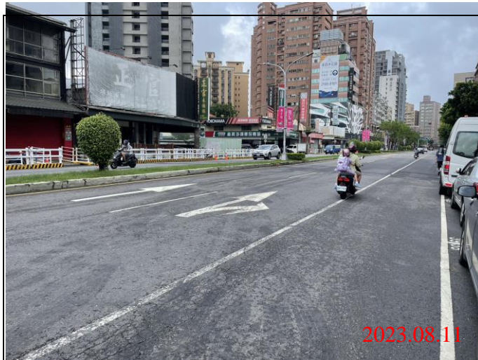
巡查日期地點：112.08.11/ Y21車站 照片說明：路面狀況
