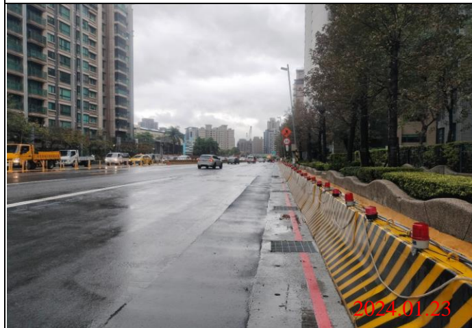
巡查日期地點：113.01.23/ Y23車站 照片說明：路面狀況
