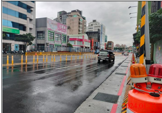
巡查日期地點：113.01.23/ Y21車站 照片說明：路面狀況
