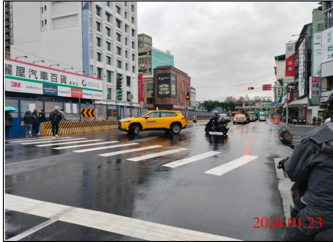
巡查日期地點：113.01.23/ Y21車站 照片說明：路面狀況
