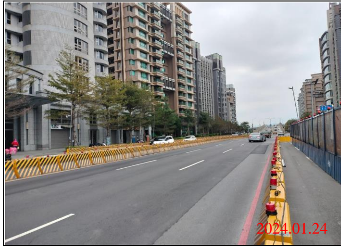
巡查日期地點：113.01.24/ Y23車站 照片說明：路面狀況
