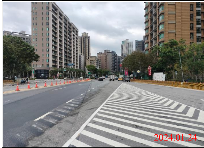
巡查日期地點：113.01.24/ Y22車站 照片說明：路面狀況
