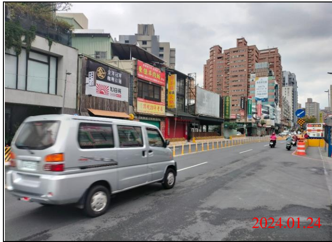
巡查日期地點：113.01.24/ Y21車站 照片說明：路面狀況
