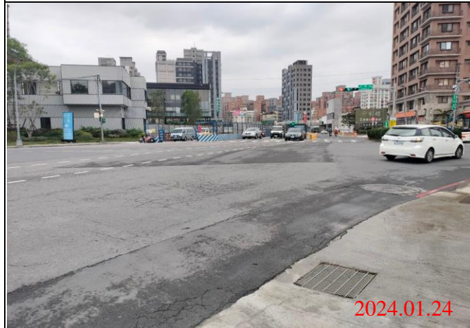
巡查日期地點：113.01.24/ Y22車站 照片說明：路面狀況
