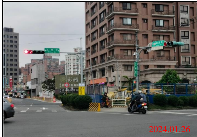
巡查日期地點：113.01.26/ Y22車站 照片說明：牌面設置狀況
