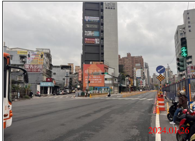
巡查日期地點：113.01.26/ Y21車站 照片說明：路面狀況
