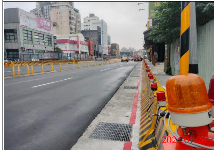
巡查日期地點：113.01.26/ Y21車站 照片說明：路面狀況
