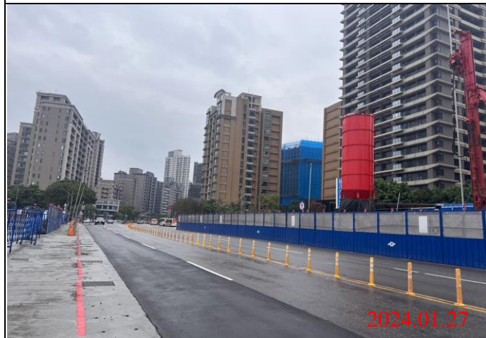
巡查日期地點：113.01.27/ Y22車站 照片說明：路面狀況
