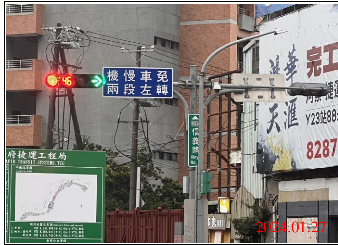
巡查日期地點：113.01.27/ Y21車站 照片說明：牌面設置狀況
