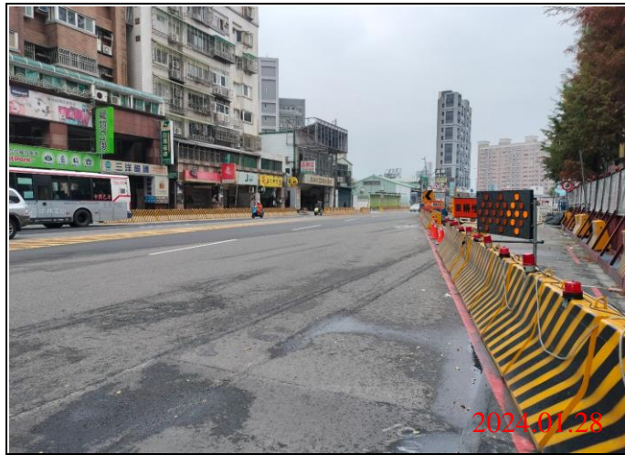
巡查日期地點：113.01.28/ Y22車站 照片說明：路面狀況
