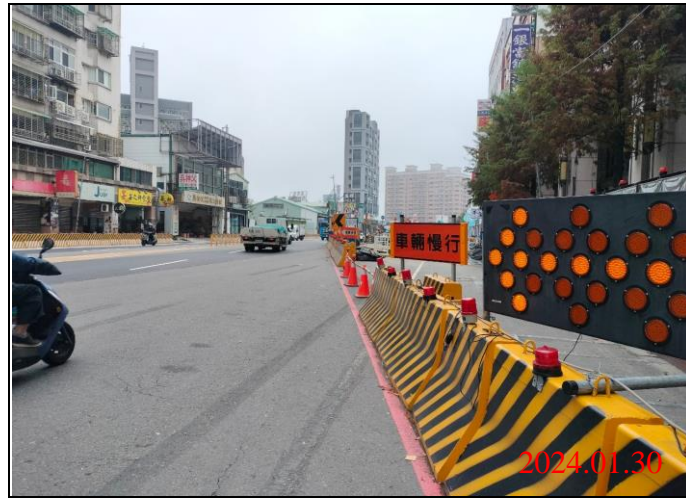
巡查日期地點：113.01.30/ Y22車站 照片說明：路面狀況
