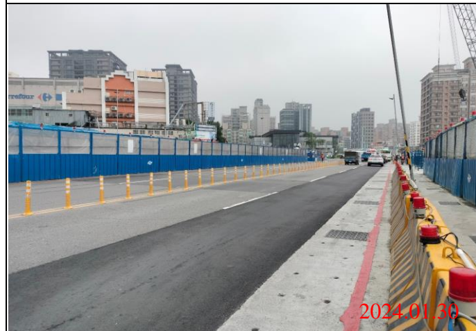
巡查日期地點：113.01.30/ Y22車站 照片說明：路面狀況
