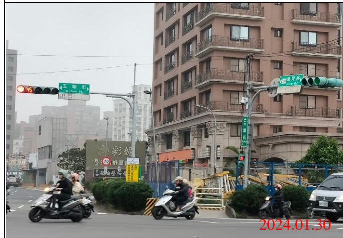
巡查日期地點：113.01.30/ Y22車站 照片說明：牌面設置狀況
