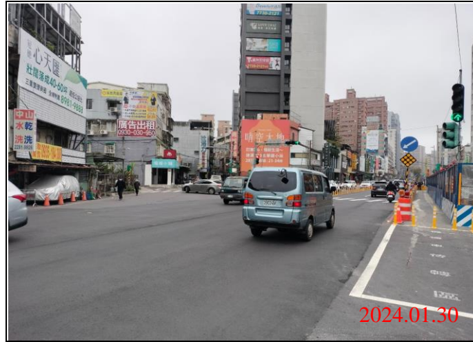
巡查日期地點：113.01.30/ Y21車站 照片說明：路面狀況
