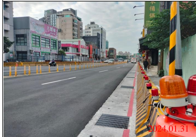
巡查日期地點：113.01.31/ Y21車站 照片說明：路面狀況
