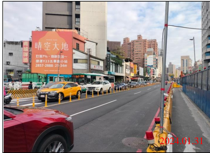
巡查日期地點：113.01.31/ Y21車站 照片說明：路面狀況
