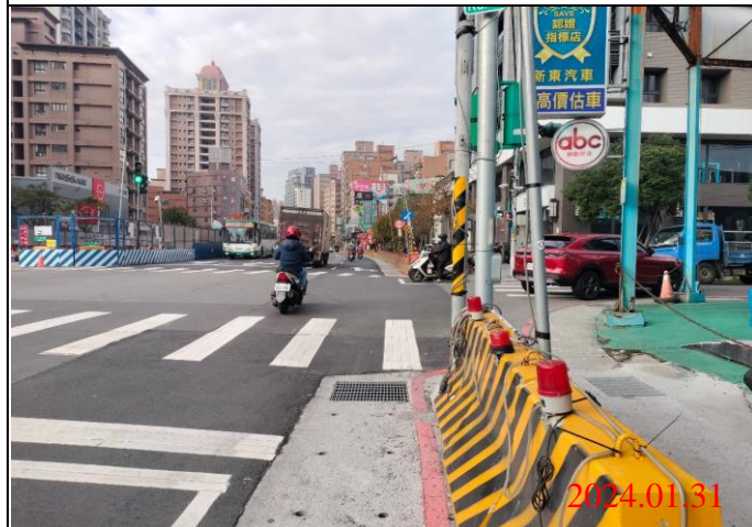
巡查日期地點：113.01.31/ Y22車站 照片說明：路面狀況
