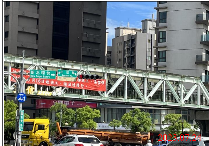
巡查日期地點：112.07.24/ Y23車站 照片說明：牌面設置狀況
