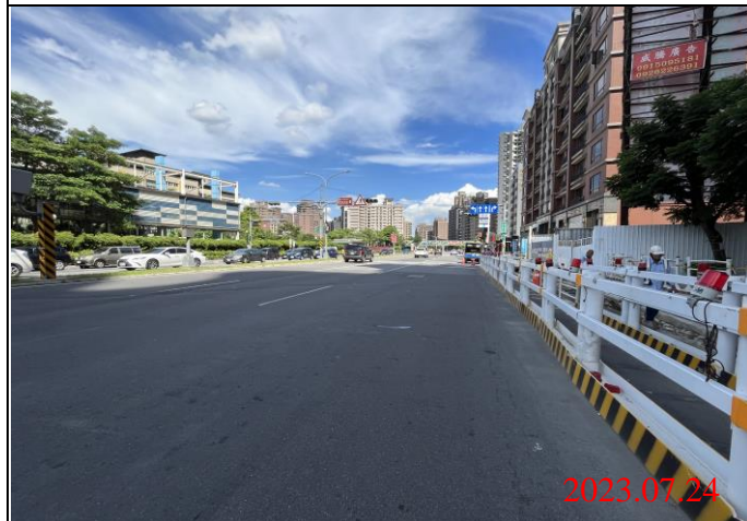
巡查日期地點：112.07.24/ Y23車站 照片說明：路面狀況
