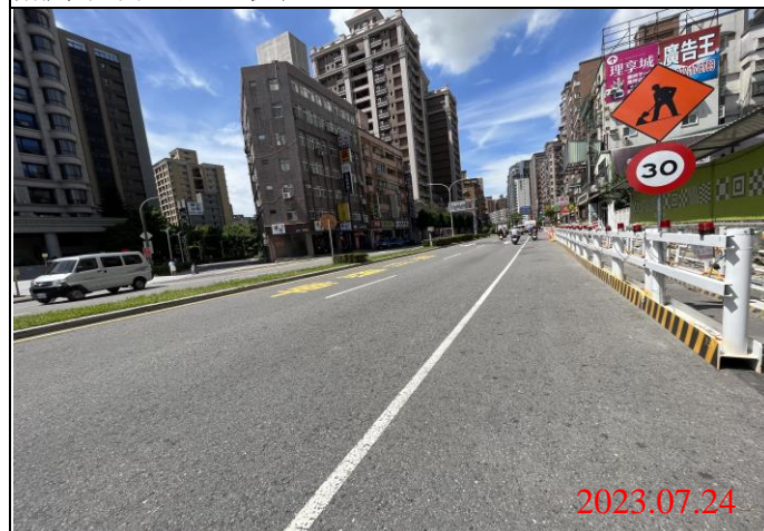
巡查日期地點：112.07.24/ Y22車站 照片說明：路面狀況
