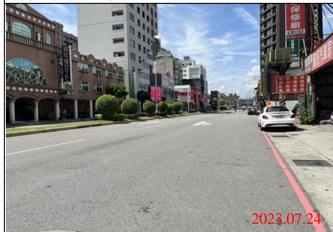
巡查日期地點：112.07.24/ Y21車站 照片說明：路面狀況
