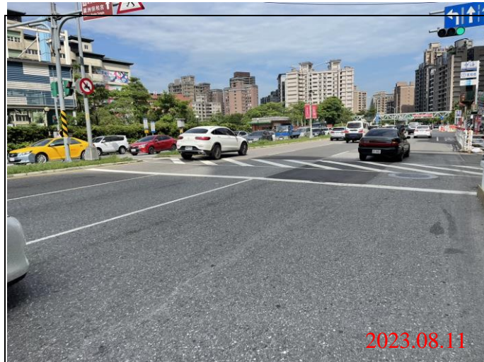
巡查日期地點：112.08.11/ Y23車站 照片說明：路面狀況
