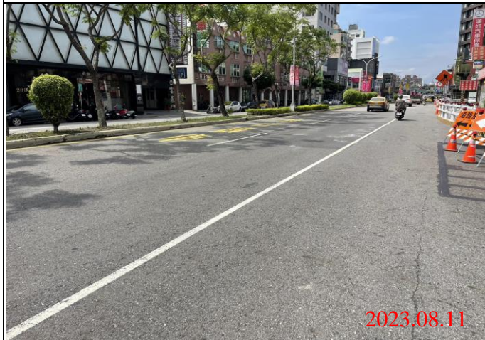
巡查日期地點：112.08.11/ Y21車站 照片說明：路面狀況
