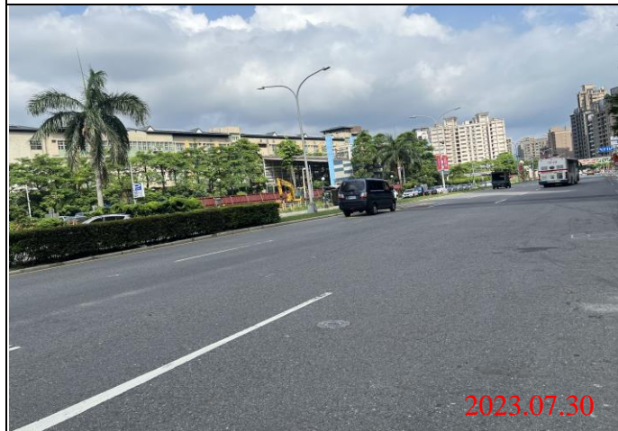
巡查日期地點：112.07.30/ Y23車站 照片說明：路面狀況
