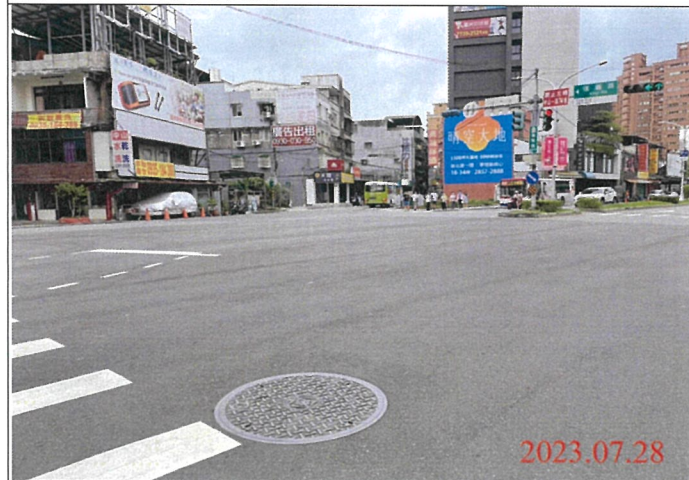
巡查日期地點：112.07.28/ Y21車站 照片說明：路面狀況
