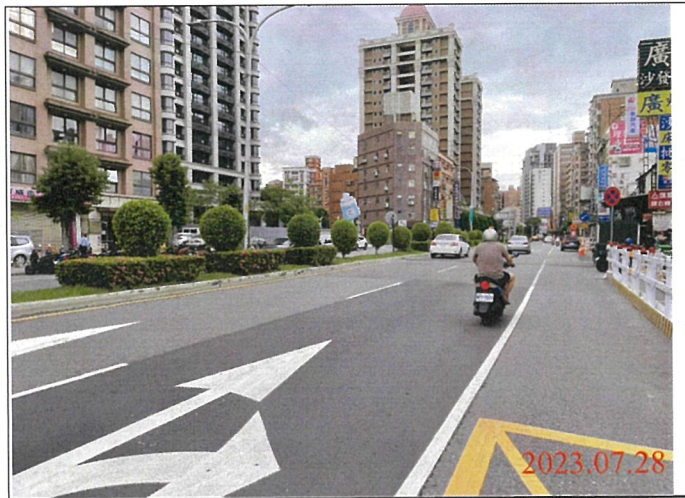
巡查日期地點：112.07.28/ Y22車站 照片說明：路面狀況
