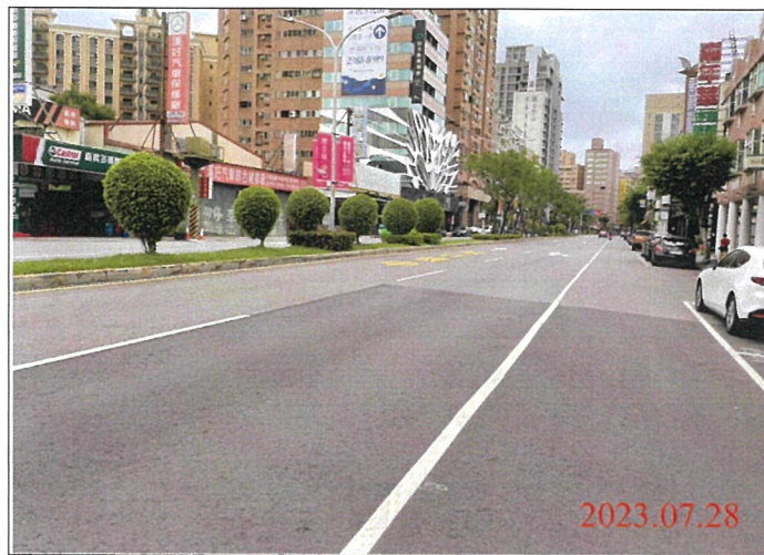
巡查日期地點：112.07.28/ Y21車站 照片說明：路面狀況
