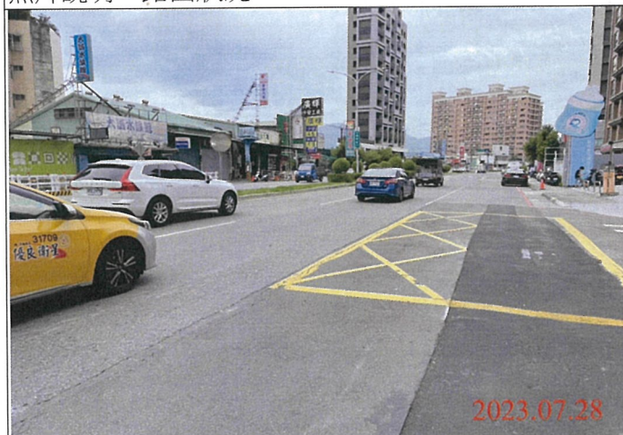
巡查日期地點：112.07.28/ Y22車站 照片說明：路面狀況
