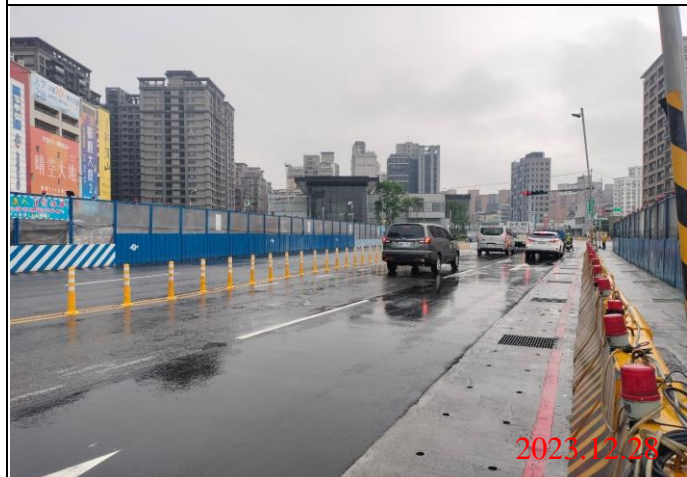
巡查日期地點：112.12.28/ Y22車站 照片說明：路面狀況
