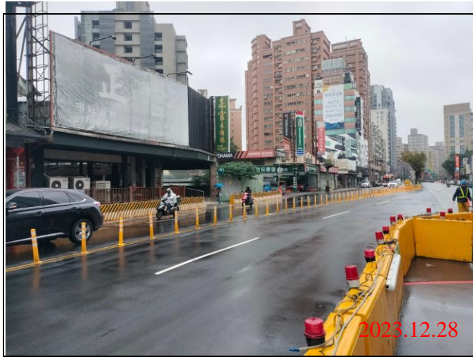
巡查日期地點：112.12.28/ Y21車站 照片說明：路面狀況
