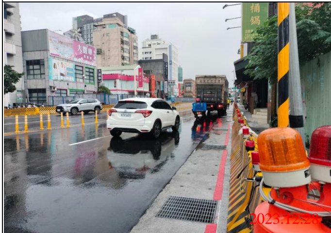
巡查日期地點：112.12.28/ Y21車站 照片說明：路面狀況
