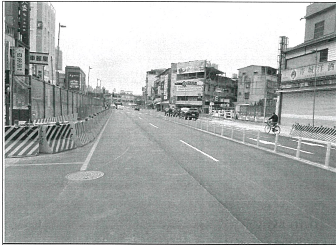
巡查日期地點：113.01.01/ Y21車站 照片說明：路面狀況
