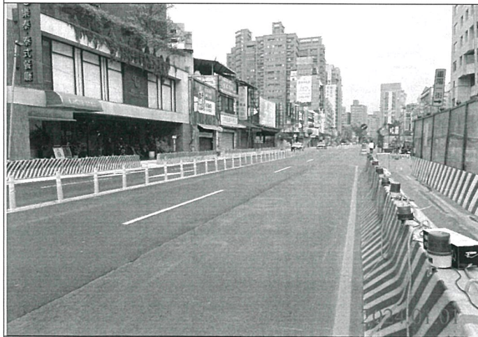
巡查日期地點：113.01.01/ Y21車站 照片說明：路面狀況
