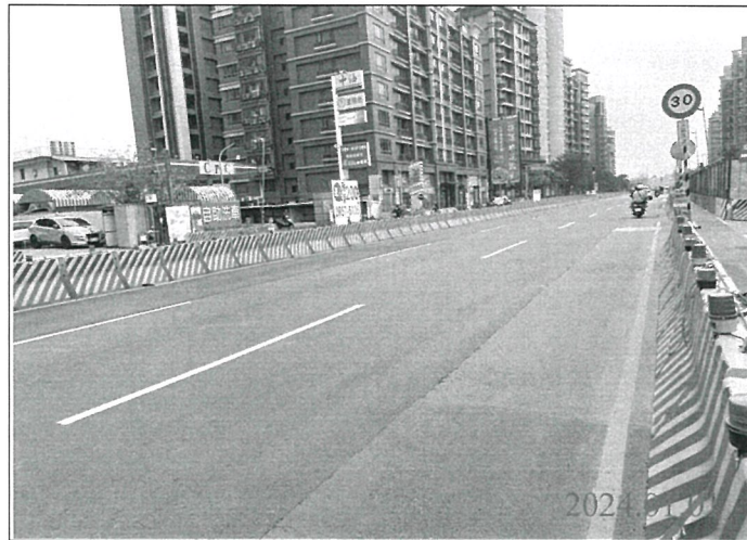
巡查日期地點：113.01.01/ Y23車站 照片說明：路面狀況
