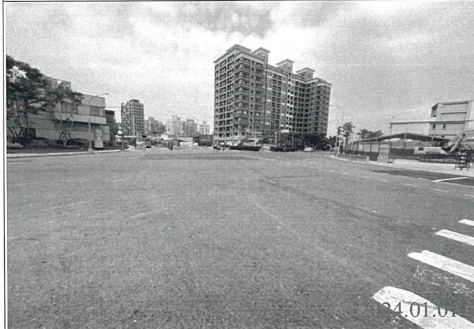
巡查日期地點：113.01.01/ Y22車站 照片說明：路面狀況
