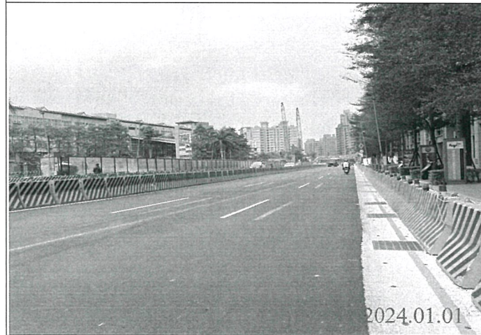
巡查日期地點：113.01.01/ Y23車站 照片說明：路面狀況
