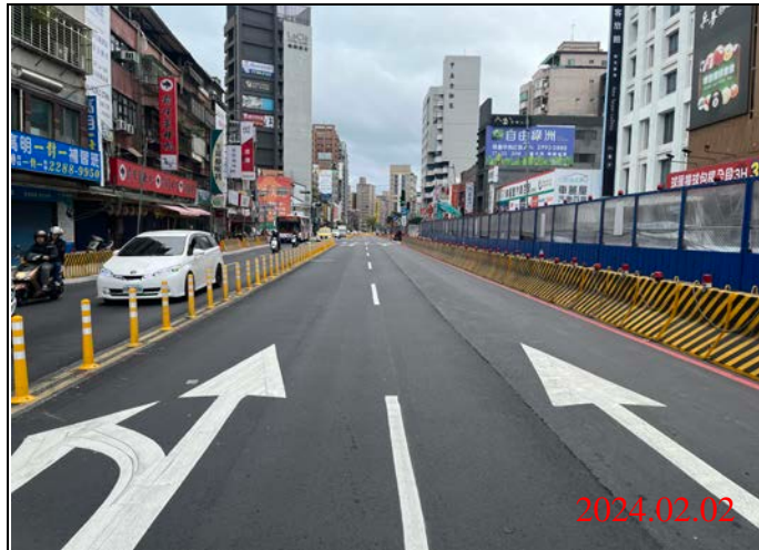
巡查日期地點：113.02.02/ Y21車站 照片說明：路面狀況
