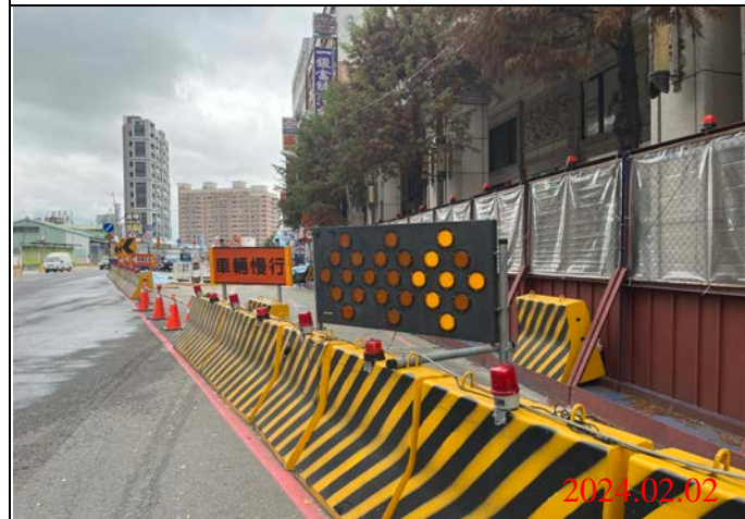
巡查日期地點：113.02.02/ Y22車站 照片說明：牌面設置狀況
