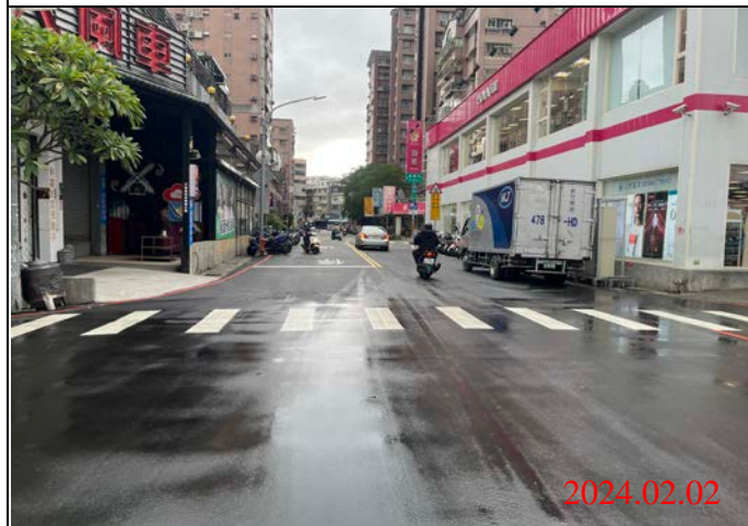
巡查日期地點：113.02.02/ Y21車站 照片說明：路面狀況
