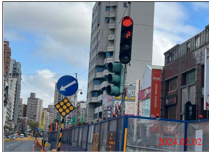
巡查日期地點：113.02.02/ Y21車站 照片說明：牌面設置狀況
