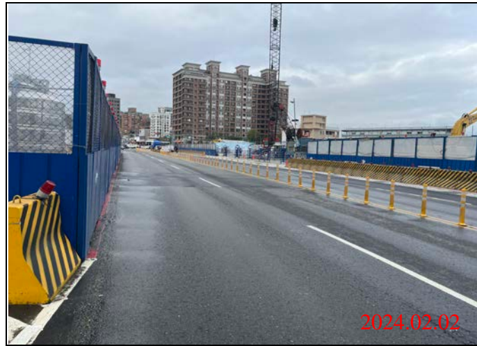
巡查日期地點：113.02.02/ Y22車站 照片說明：路面狀況
