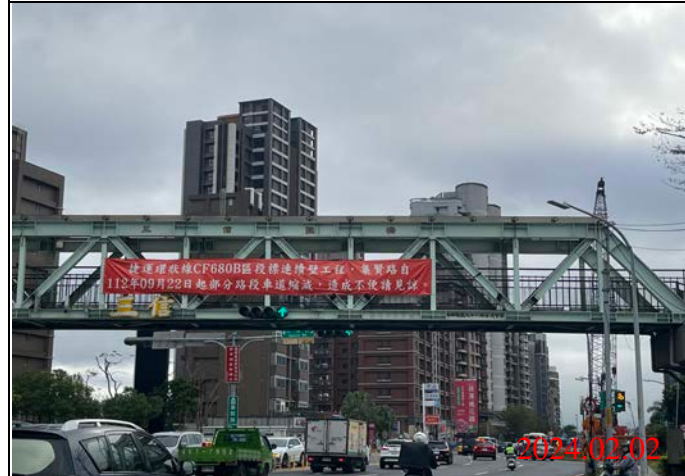
巡查日期地點：113.02.02/ Y23車站 照片說明：牌面設置狀況
