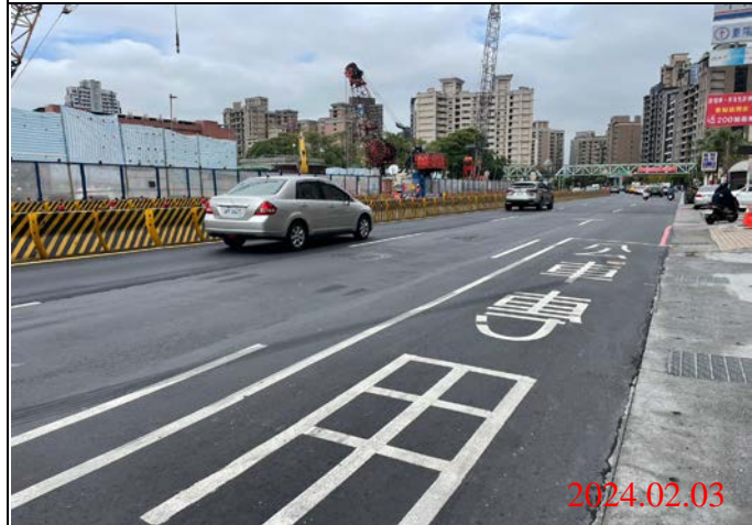
巡查日期地點：113.02.03/ Y23車站 照片說明：路面狀況
