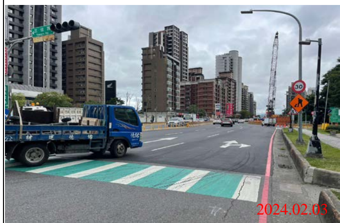
巡查日期地點：113.02.03/ Y23車站 照片說明：路面狀況
