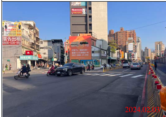
巡查日期地點：113.02.03/ Y21車站 照片說明：路面狀況
