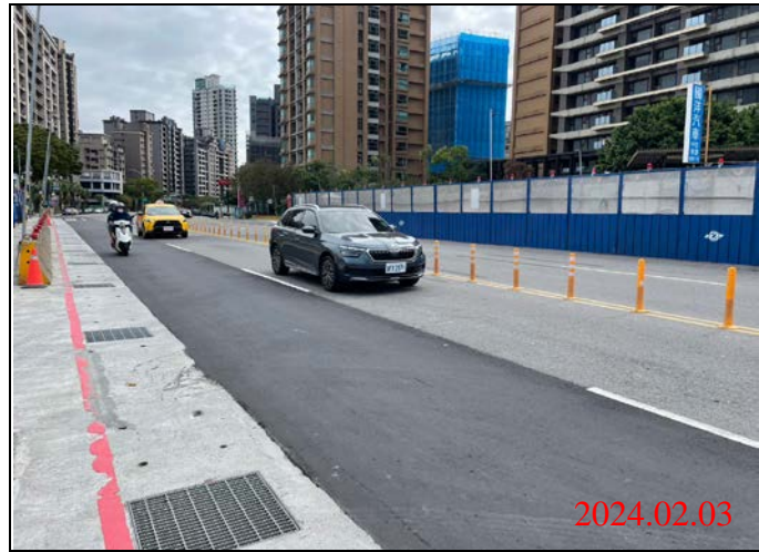
巡查日期地點：113.02.03/ Y22車站 照片說明：路面狀況
