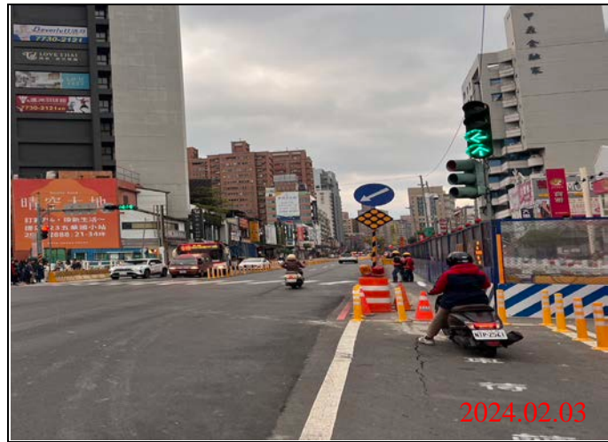
巡查日期地點：113.02.03/ Y21車站 照片說明：牌面設置狀況
