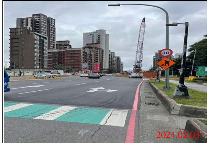
巡查日期地點：113.02.03/ Y23車站 照片說明：牌面設置狀況
