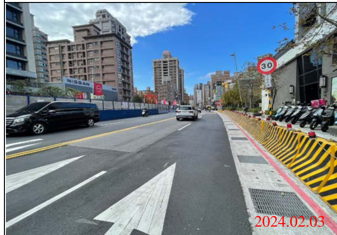
巡查日期地點：113.02.03/ Y22車站 照片說明：路面狀況
