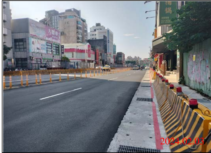
巡查日期地點：113.02.03/ Y21車站 照片說明：路面狀況
