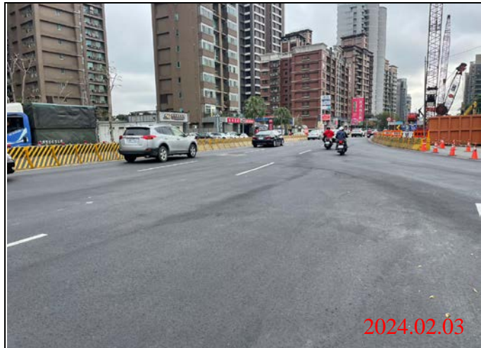
巡查日期地點：113.02.03/ Y23車站 照片說明：路面狀況
