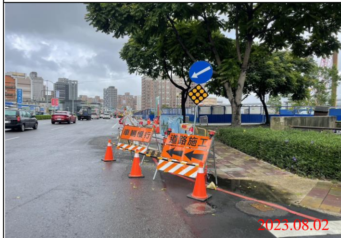
巡查日期地點：112.08.02/ Y22車站 照片說明：牌面設置狀況
