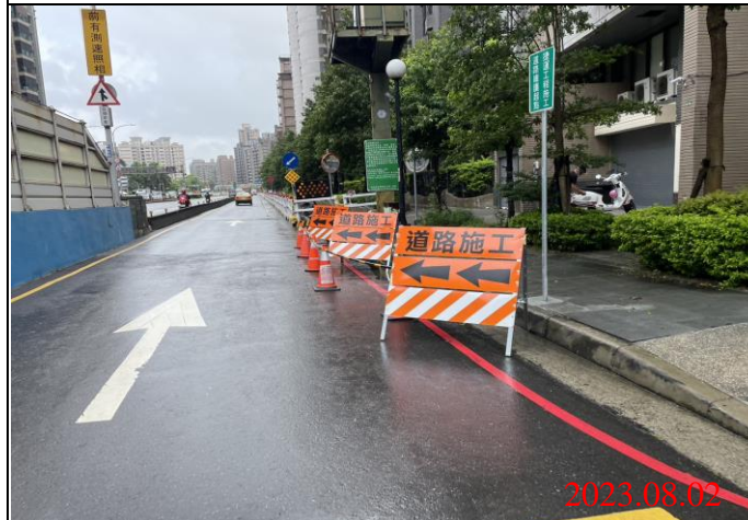
巡查日期地點：112.08.02/ Y23車站 照片說明：牌面設置狀況
