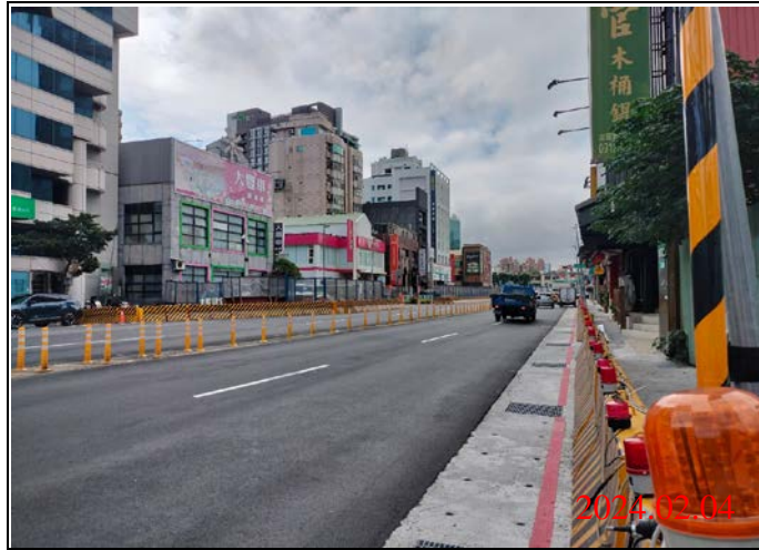
巡查日期地點：113.02.04/ Y21車站 照片說明：路面狀況
