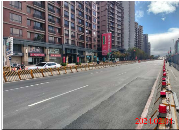
巡查日期地點：113.02.04/ Y23車站 照片說明：路面狀況
