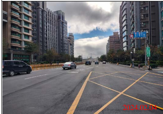
巡查日期地點：113.02.04/ Y23車站 照片說明：路面狀況
