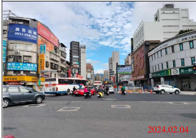
巡查日期地點：113.02.04/ Y21車站 照片說明：路面狀況
