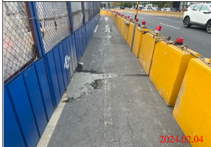
巡查日期地點：113.02.04/ Y23車站 照片說明：路面龜裂修繕完畢
