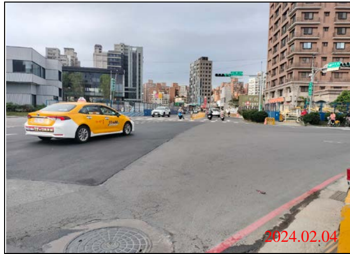
巡查日期地點：113.02.04/ Y22車站 照片說明：路面狀況
