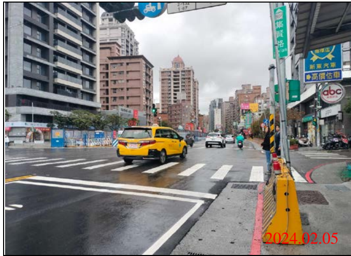
巡查日期地點：113.02.05/ Y22車站 照片說明：路面狀況
