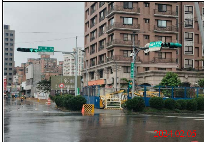
巡查日期地點：113.02.05/ Y22車站 照片說明：牌面設置狀況
