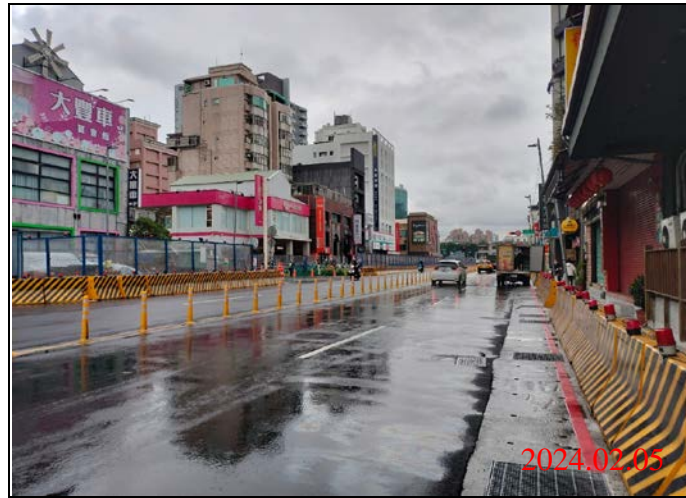
巡查日期地點：113.02.05/ Y21車站 照片說明：路面狀況
