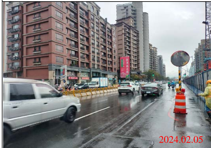
巡查日期地點：113.02.05/ Y23車站 照片說明：路面狀況
