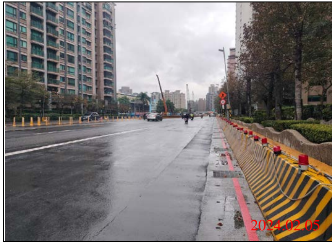
巡查日期地點：113.02.05/ Y23車站 照片說明：路面狀況
