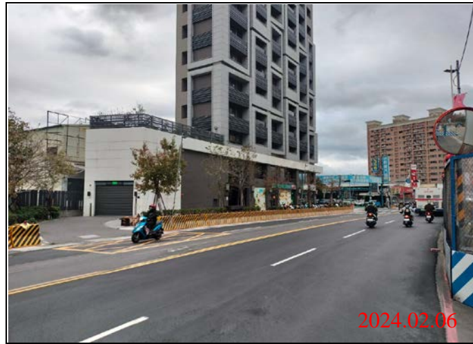
巡查日期地點：113.02.06/ Y22車站 照片說明：路面狀況
