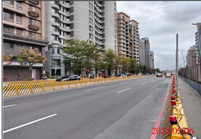
巡查日期地點：113.02.06/ Y23車站 照片說明：路面狀況
