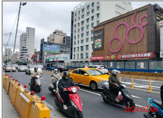
巡查日期地點：113.02.06/ Y21車站 照片說明：路面狀況
