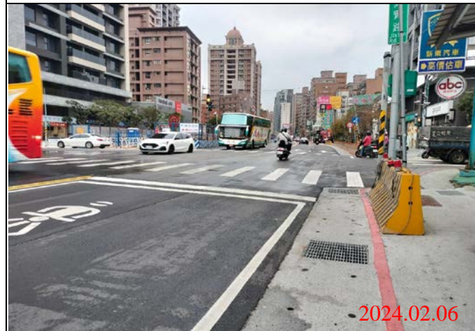
巡查日期地點：113.02.06/ Y22車站 照片說明：路面狀況
