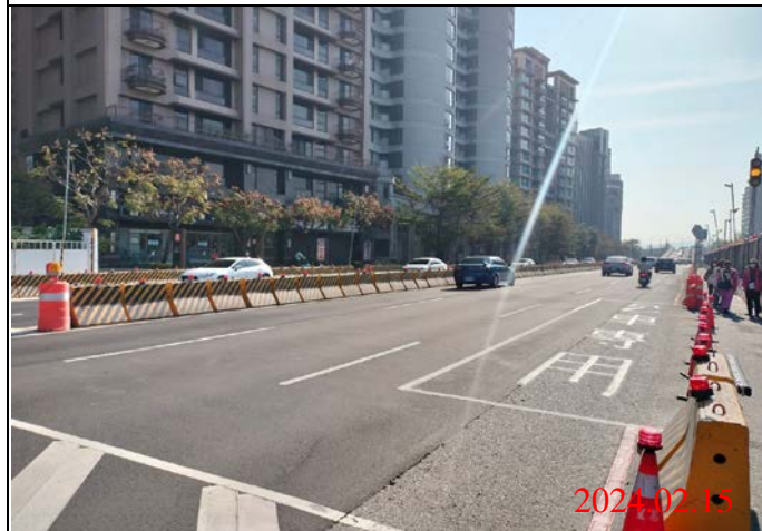
巡查日期地點：113.02.15/ Y23車站 照片說明：路面狀況
