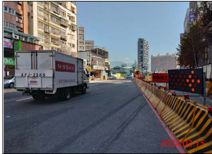
巡查日期地點：113.02.15/ Y22車站 照片說明：路面狀況
