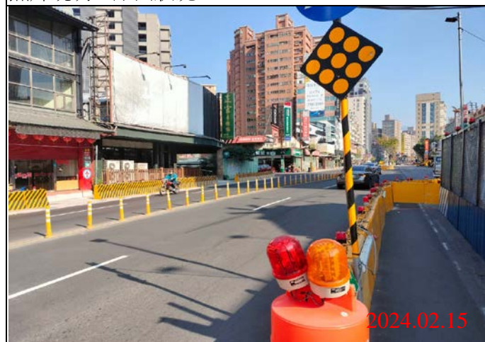
巡查日期地點：113.02.15/ Y21車站 照片說明：路面狀況
