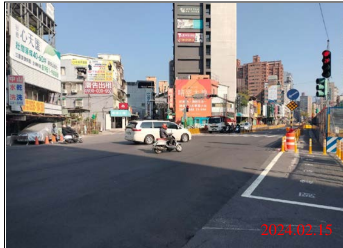
巡查日期地點：113.02.15/ Y21車站 照片說明：路面狀況
