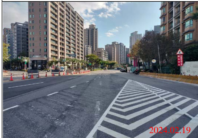
巡查日期地點：113.02.19/ Y22車站 照片說明：路面狀況
