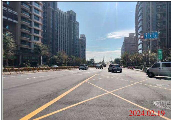
巡查日期地點：113.02.19/ Y23車站 照片說明：路面狀況
