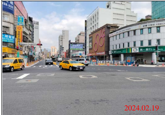
巡查日期地點：113.02.19/ Y21車站 照片說明：路面狀況
