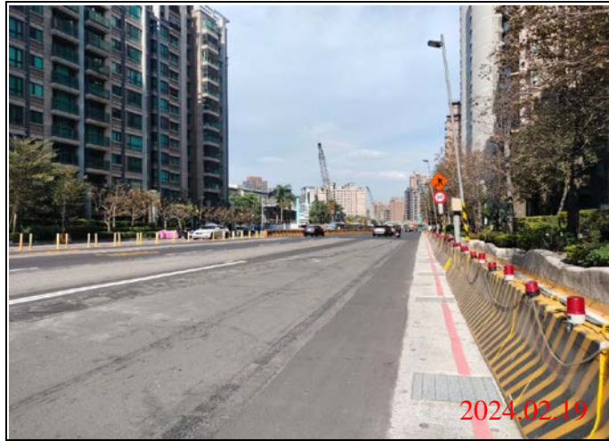
巡查日期地點：113.02.19/ Y23車站 照片說明：路面狀況
