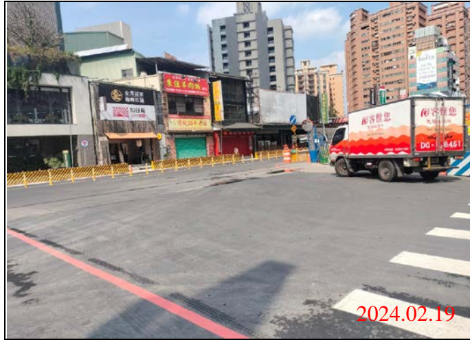
巡查日期地點：113.02.19/ Y21車站 照片說明：路面狀況
