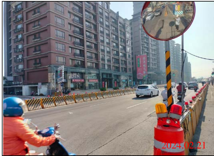
巡查日期地點：113.02.21/ Y23車站 照片說明：路面狀況
