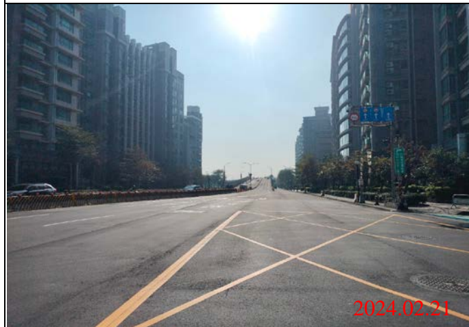
巡查日期地點：113.02.21/ Y23車站 照片說明：路面狀況
