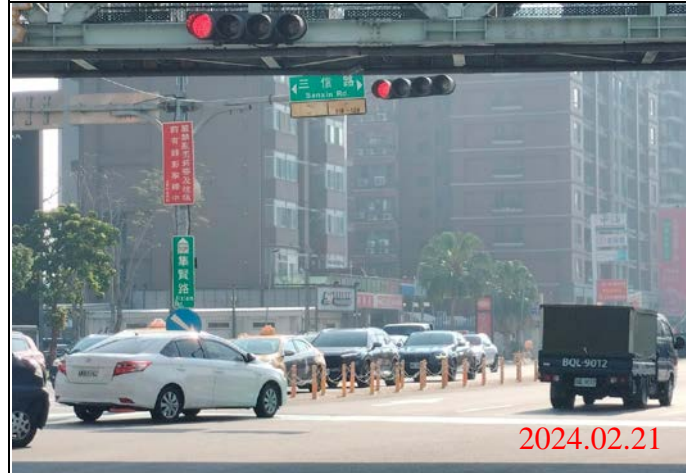
巡查日期地點：113.02.21/ Y23車站 照片說明：牌面設置狀況
