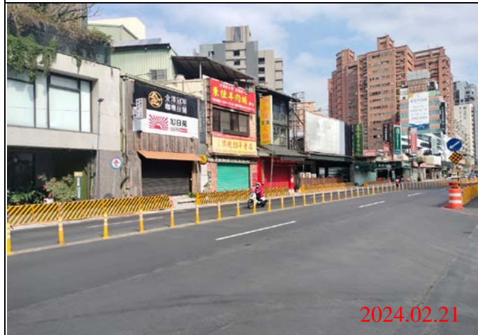
巡查日期地點：113.02.21/ Y21車站 照片說明：路面狀況
