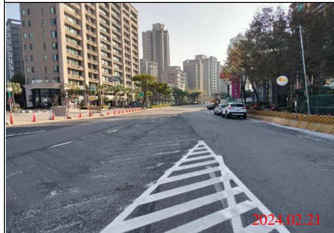
巡查日期地點：113.02.21/ Y22車站 照片說明：路面狀況
