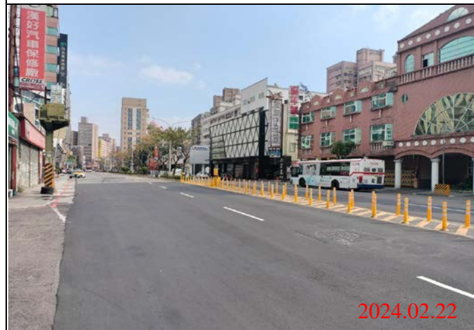
巡查日期地點：113.02.22/ Y21車站 照片說明：路面狀況
