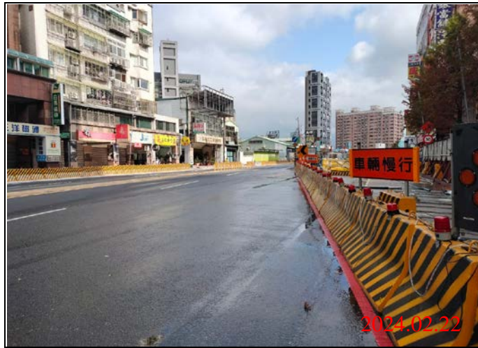
巡查日期地點：113.02.22/ Y22車站 照片說明：路面狀況
