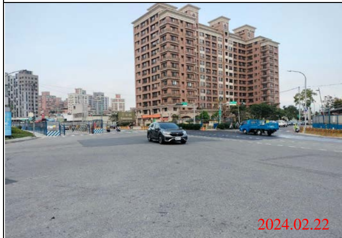
巡查日期地點：113.02.22/ Y22車站 照片說明：路面狀況
