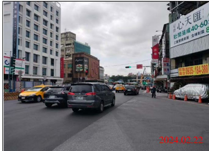
巡查日期地點：113.02.22/ Y21車站 照片說明：路面狀況
