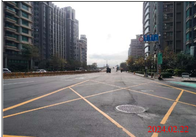
巡查日期地點：113.02.22/ Y23車站 照片說明：路面狀況
