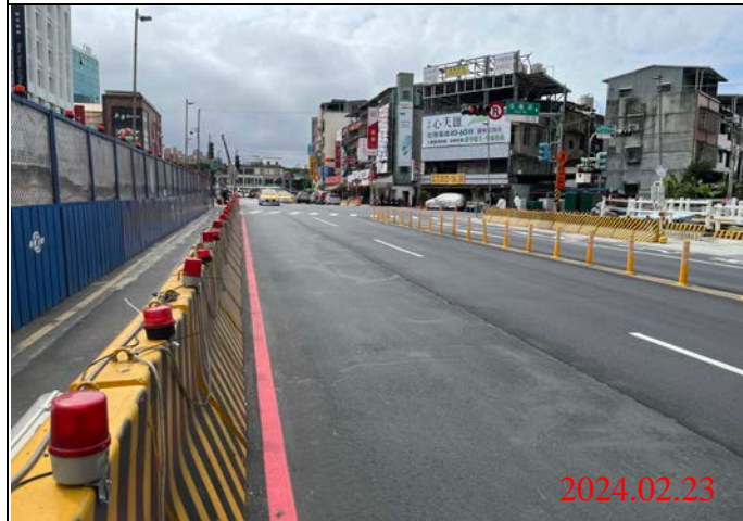
巡查日期地點：113.02.23/ Y21車站 照片說明：路面狀況
