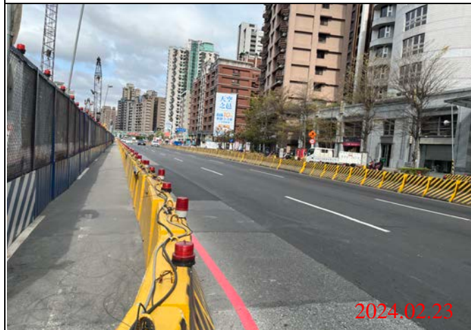
巡查日期地點：113.02.23/ Y23車站 照片說明：路面狀況
