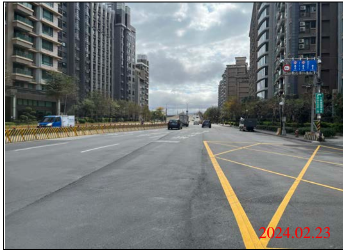
巡查日期地點：113.02.23/ Y23車站 照片說明：路面狀況
