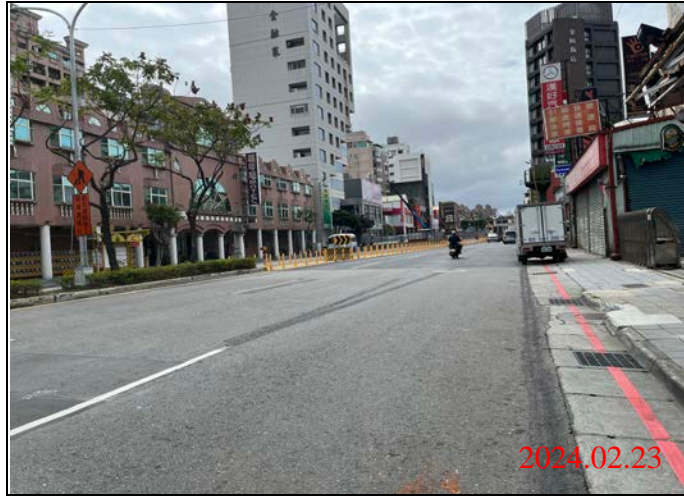
巡查日期地點：113.02.23/ Y21車站 照片說明：路面狀況
