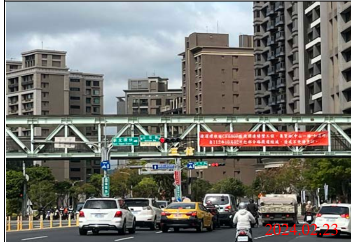
巡查日期地點：113.02.23/ Y23車站 照片說明：牌面設置狀況
