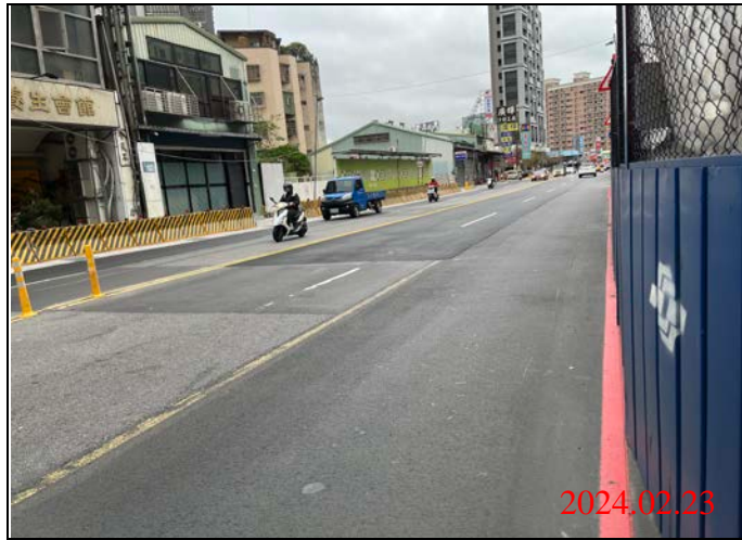
巡查日期地點：113.02.23/ Y22車站 照片說明：路面狀況
