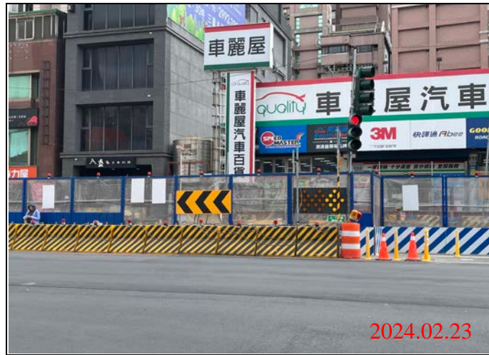
巡查日期地點：113.02.23/ Y21車站 照片說明：牌面設置狀況
