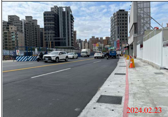
巡查日期地點：113.02.23/ Y22車站 照片說明：路面狀況
