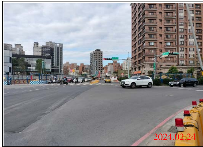
巡查日期地點：113.02.24/ Y22車站 照片說明：路面狀況
