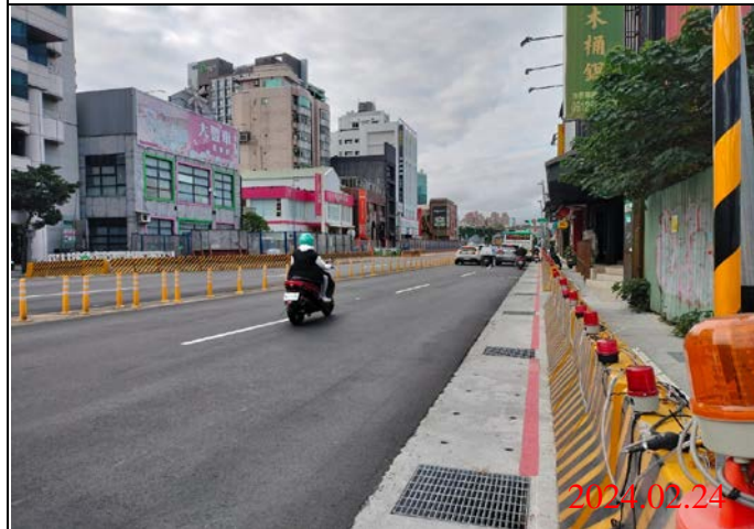
巡查日期地點：113.02.24/ Y21車站 照片說明：路面狀況
