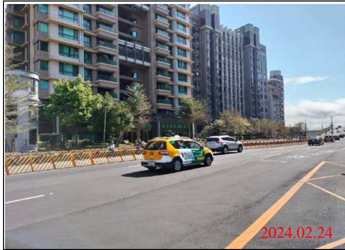
巡查日期地點：113.02.24/ Y23車站 照片說明：路面狀況
