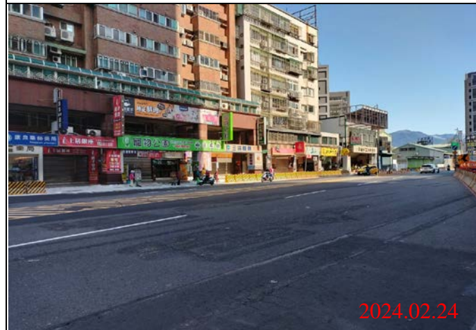
巡查日期地點：113.02.24/ Y22車站 照片說明：路面狀況
