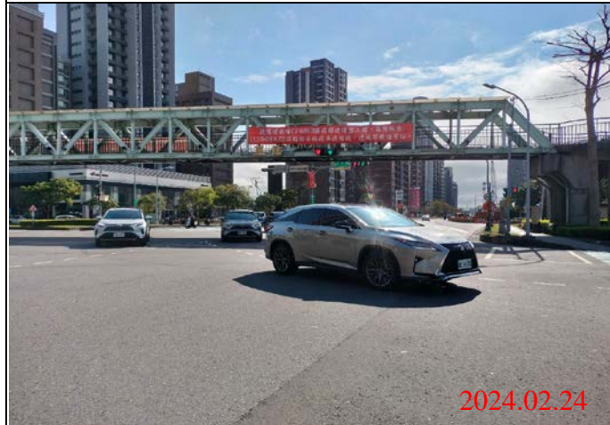
巡查日期地點：113.02.24/ Y23車站 照片說明：路面狀況
