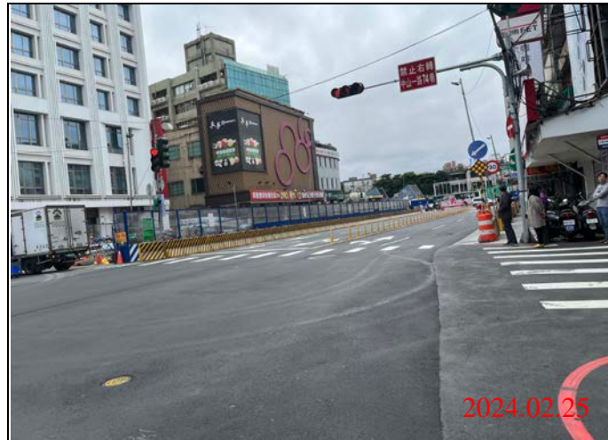
巡查日期地點：113.02.25/ Y21車站 照片說明：路面狀況
