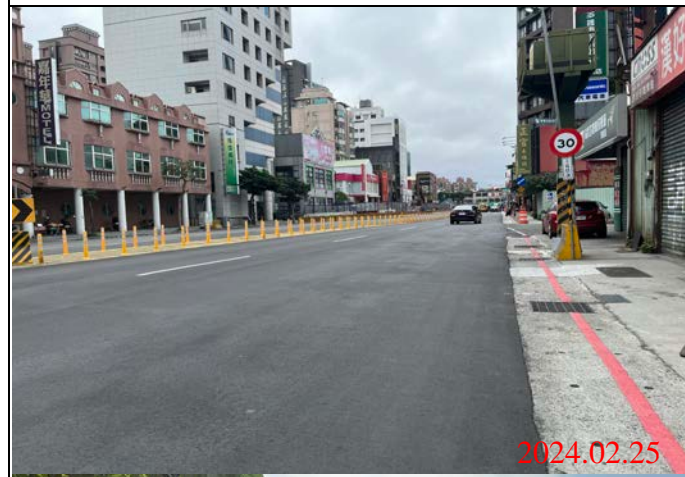
巡查日期地點：113.02.25/ Y21車站 照片說明：路面狀況
