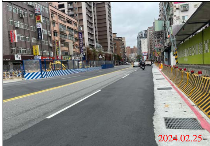
巡查日期地點：113.02.25/ Y22車站 照片說明：路面狀況
