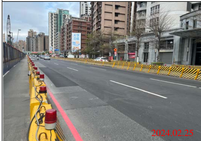
巡查日期地點：113.02.25/ Y23車站 照片說明：路面狀況
