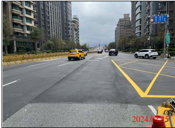
巡查日期地點：113.02.25/ Y23車站 照片說明：路面狀況
