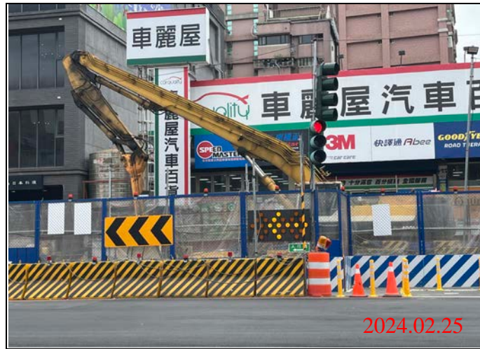
巡查日期地點：113.02.25/ Y21車站 照片說明：牌面設置狀況
