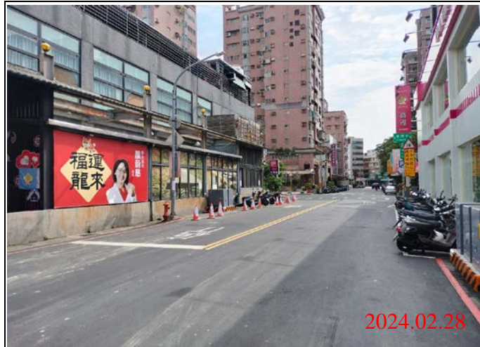
巡查日期地點：113.02.28/ Y21車站 照片說明：路面狀況
