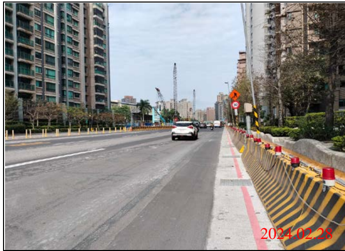
巡查日期地點：113.02.28/ Y23車站 照片說明：路面狀況
