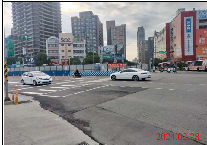
巡查日期地點：113.02.28/ Y22車站 照片說明：路面狀況
