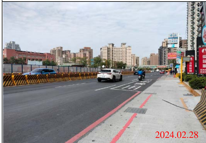
巡查日期地點：113.02.28/ Y23車站 照片說明：路面狀況
