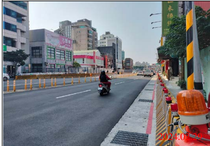
巡查日期地點：113.02.29/ Y21車站 照片說明：路面狀況
