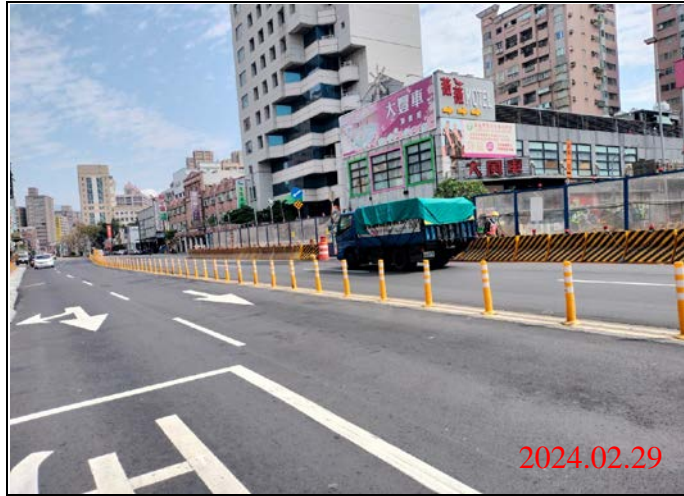
巡查日期地點：113.02.29/ Y21車站 照片說明：路面狀況
