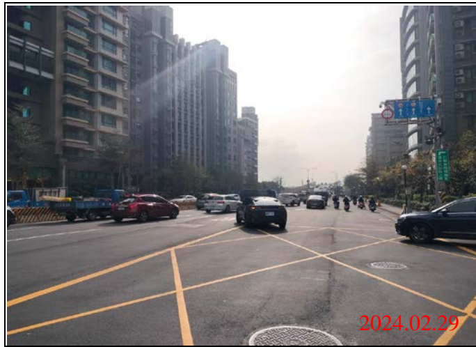
巡查日期地點：113.02.29/ Y23車站 照片說明：路面狀況
