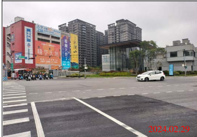
巡查日期地點：113.02.29/ Y22車站 照片說明：路面狀況
