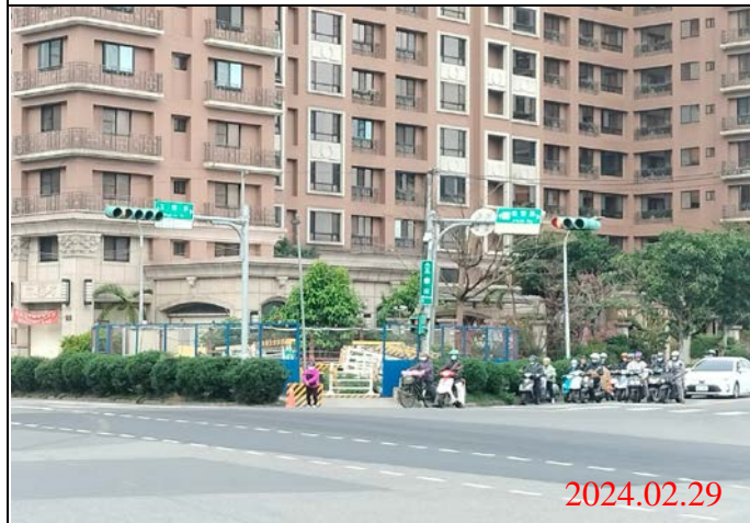
巡查日期地點：113.02.29/ Y22車站 照片說明：牌面設置狀況
