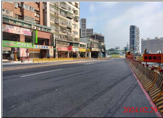
巡查日期地點：113.02.29/ Y22車站 照片說明：路面狀況
