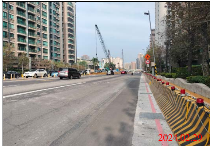
巡查日期地點：113.02.29/ Y23車站 照片說明：路面狀況
