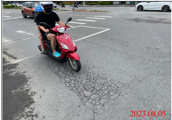
巡查日期地點：112.08.05/ Y22車站 照片說明：路面龜裂狀況
