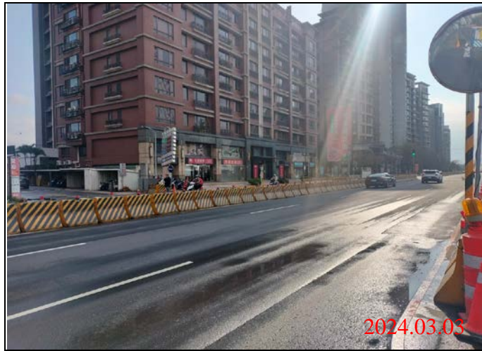
巡查日期地點：113.03.03/ Y23車站 照片說明：路面狀況
