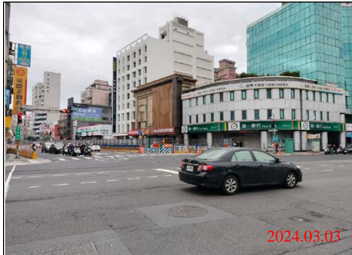
巡查日期地點：113.03.03/ Y21車站 照片說明：路面狀況
