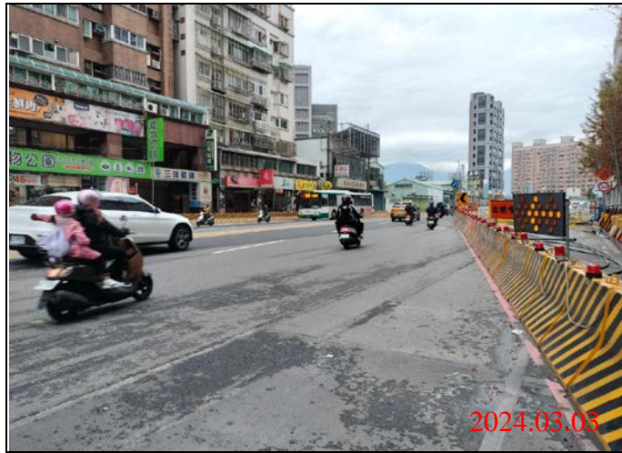
巡查日期地點：113.03.03/ Y22車站 照片說明：路面狀況
