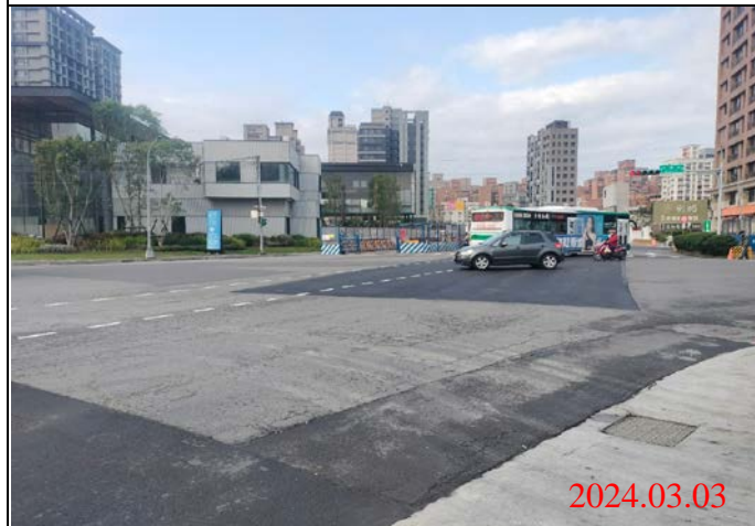
巡查日期地點：113.03.03/ Y22車站 照片說明：路面狀況
