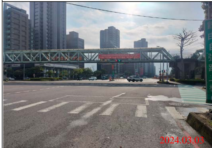
巡查日期地點：113.03.03/ Y23車站 照片說明：路面狀況
