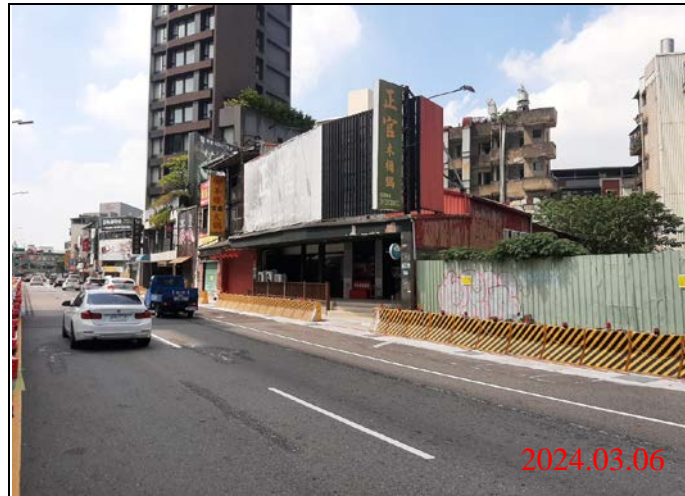
巡查日期地點：113.03.06/ Y21車站 照片說明：路面狀況
