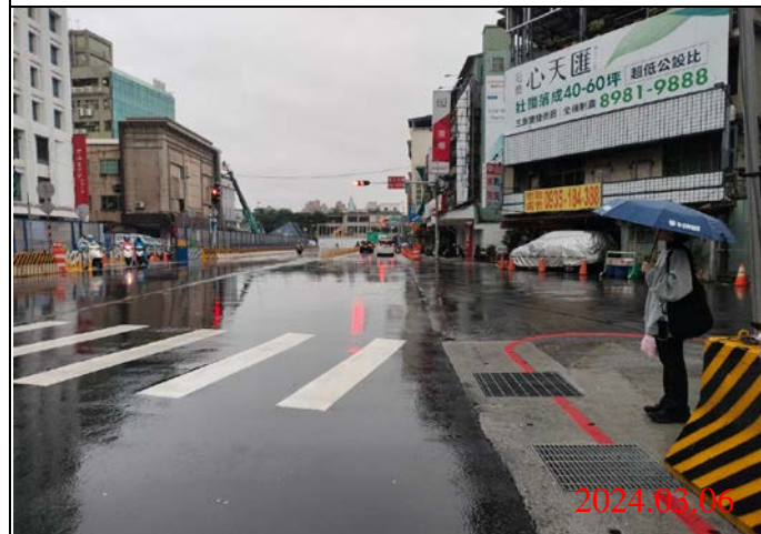
巡查日期地點：113.03.06/ Y21車站 照片說明：路面狀況
