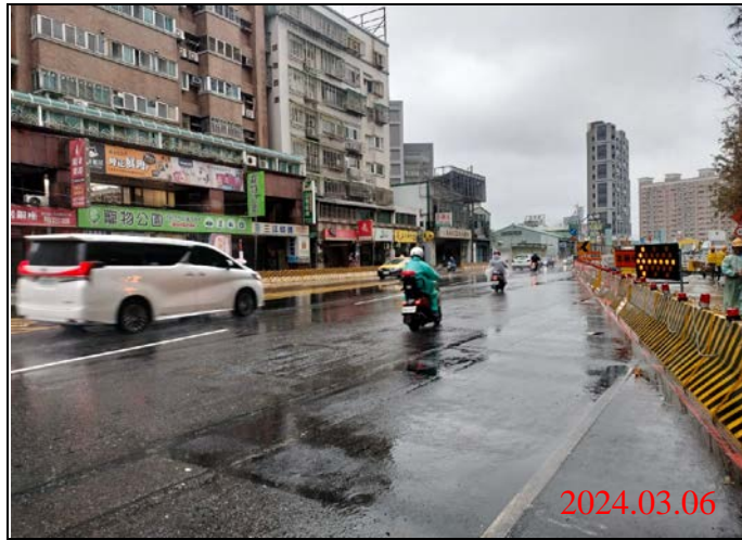
巡查日期地點：113.03.06/ Y22車站 照片說明：路面狀況
