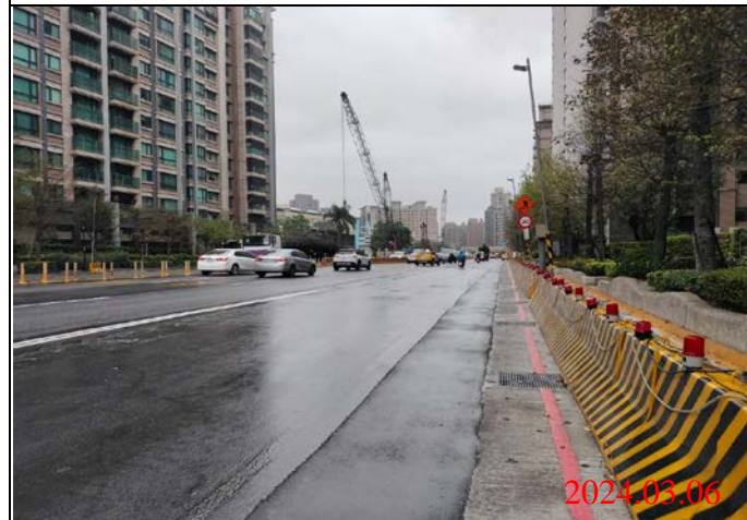
巡查日期地點：113.03.06/ Y23車站 照片說明：路面狀況
