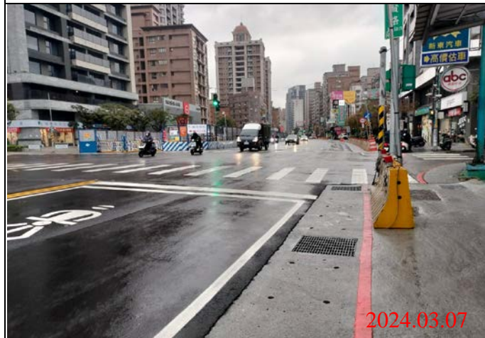
巡查日期地點：113.03.07/ Y22車站 照片說明：路面狀況
