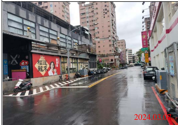
巡查日期地點：113.03.07/ Y21車站 照片說明：路面狀況
