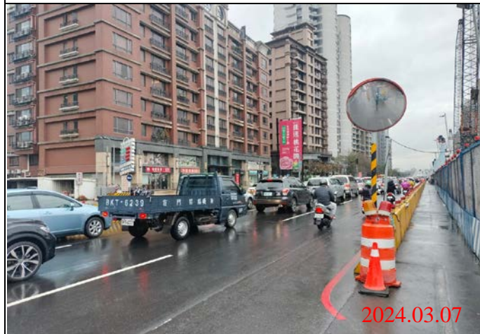
巡查日期地點：113.03.07/ Y23車站 照片說明：路面狀況
