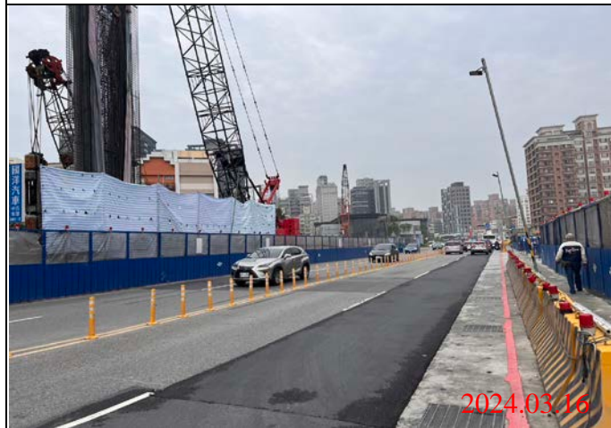
巡查日期地點：113.03.16/ Y22車站 照片說明：路面狀況
