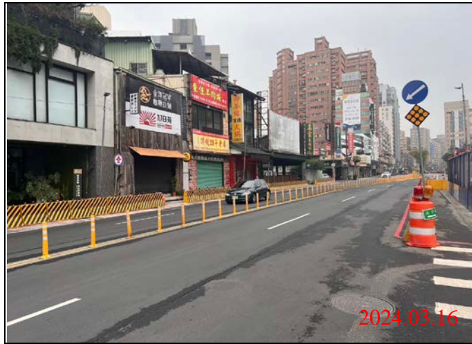
巡查日期地點：113.03.16/ Y21車站 照片說明：路面狀況
