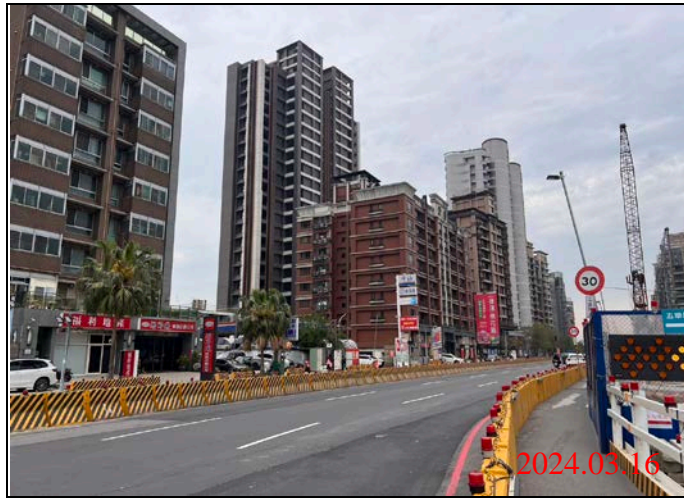
巡查日期地點：113.03.16/ Y23車站 照片說明：路面狀況
