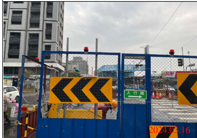
巡查日期地點：113.03.16/ Y22車站 照片說明：牌面設置狀況
