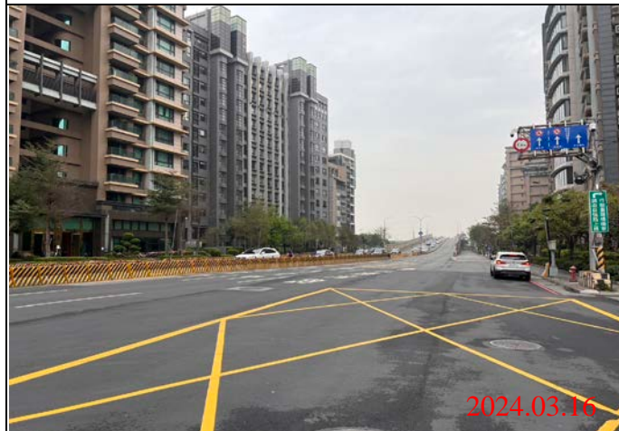
巡查日期地點：113.03.16/ Y23車站 照片說明：路面狀況
