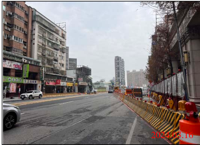
巡查日期地點：113.03.16/ Y22車站 照片說明：路面狀況
