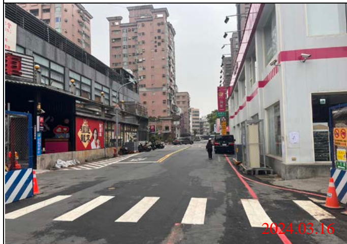
巡查日期地點：113.03.16/ Y21車站 照片說明：路面狀況
