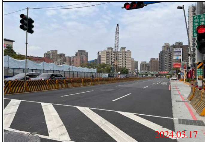
巡查日期地點：113.03.17/ Y23車站 照片說明：路面狀況
