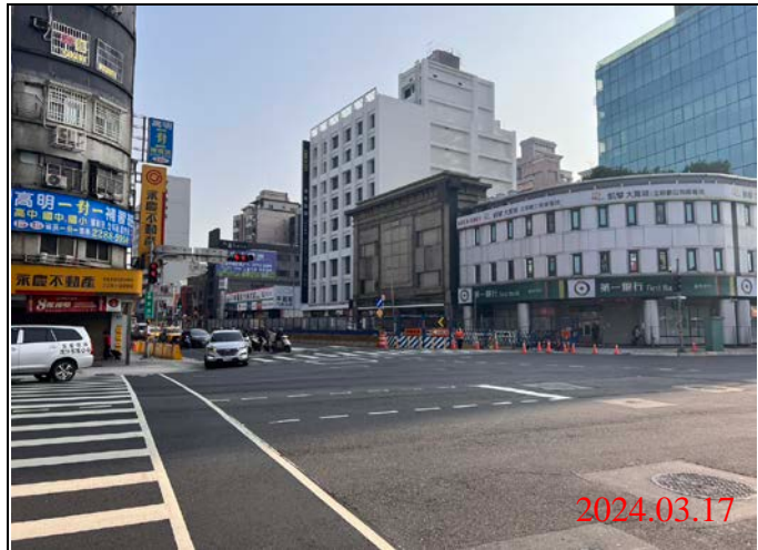
巡查日期地點：113.03.17/ Y21車站 照片說明：路面狀況
