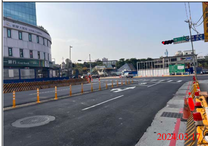
巡查日期地點：113.03.17/ Y21車站 照片說明：路面狀況
