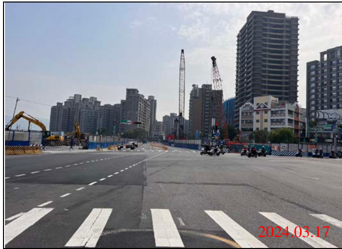
巡查日期地點：113.03.17/ Y22車站 照片說明：路面狀況
