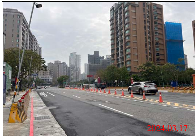
巡查日期地點：113.03.17/ Y22車站 照片說明：路面狀況
