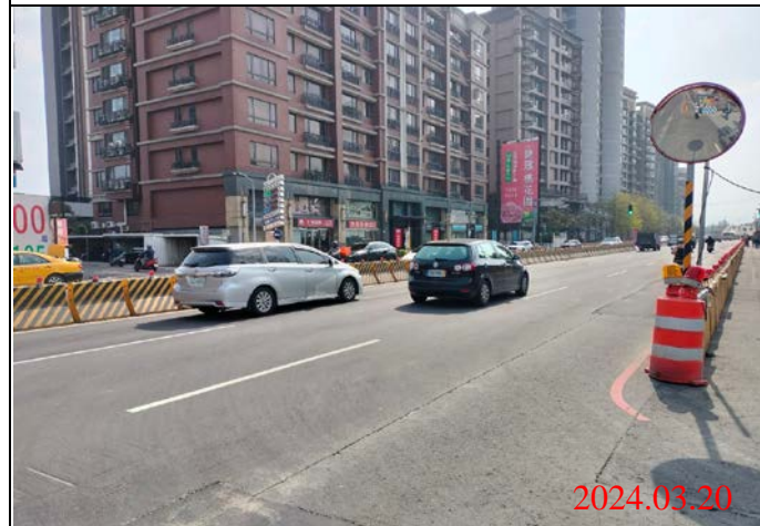
巡查日期地點：113.03.20/ Y23車站 照片說明：路面狀況
