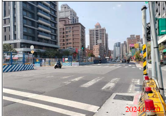
巡查日期地點：113.03.20/ Y22車站 照片說明：路面狀況
