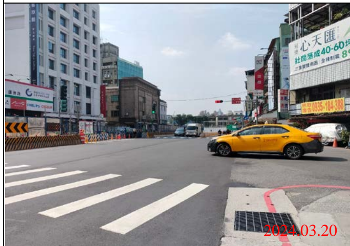
巡查日期地點：113.03.20/ Y21車站 照片說明：路面狀況
