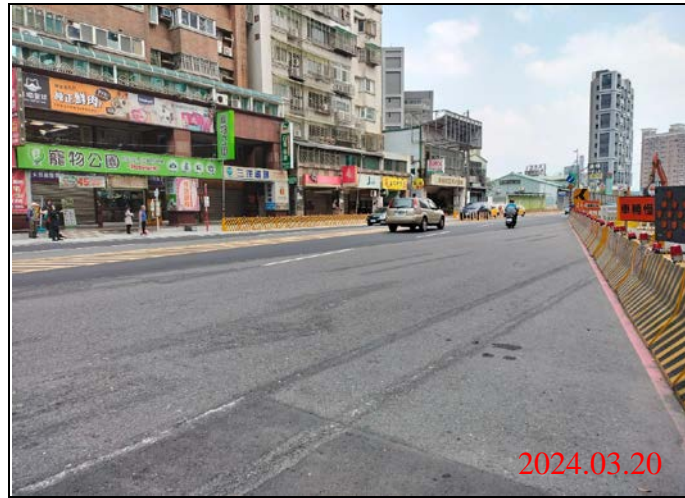
巡查日期地點：113.03.20/ Y22車站 照片說明：路面狀況
