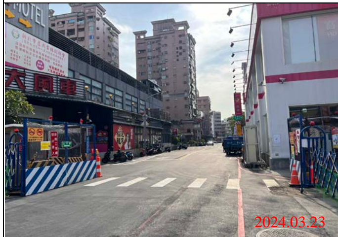
巡查日期地點：113.03.23/ Y21車站 照片說明：路面狀況
