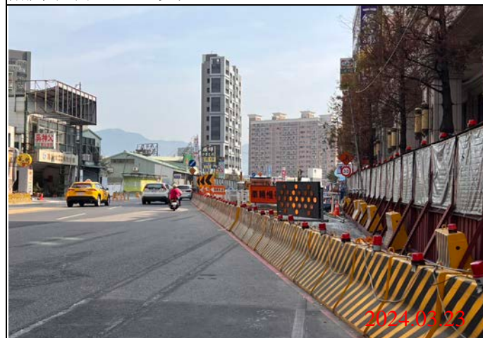
巡查日期地點：113.03.23/ Y22車站 照片說明：路面狀況
