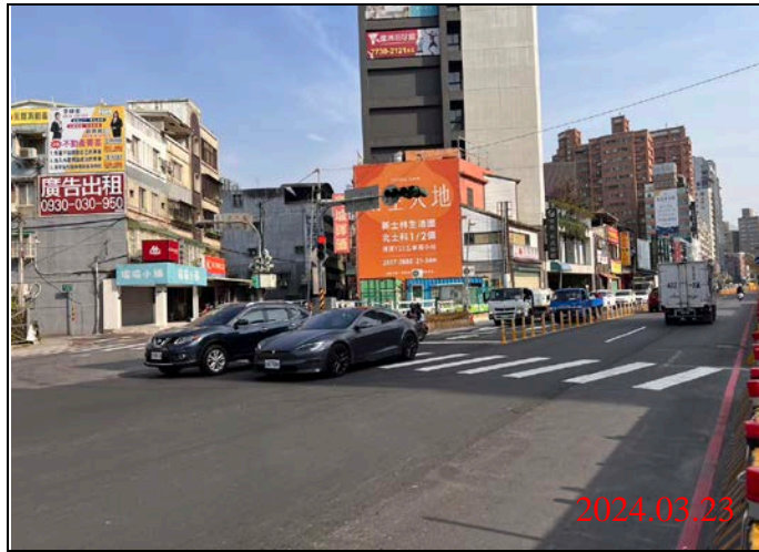
巡查日期地點：113.03.23/ Y21車站 照片說明：路面狀況
