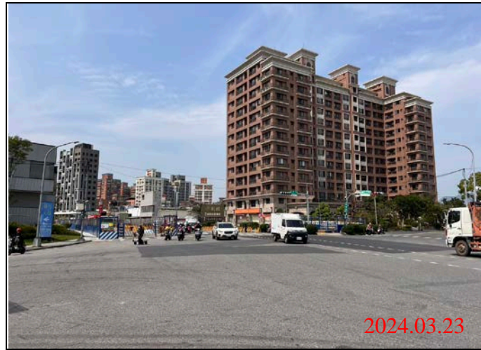
巡查日期地點：113.03.23/ Y22車站 照片說明：路面狀況
