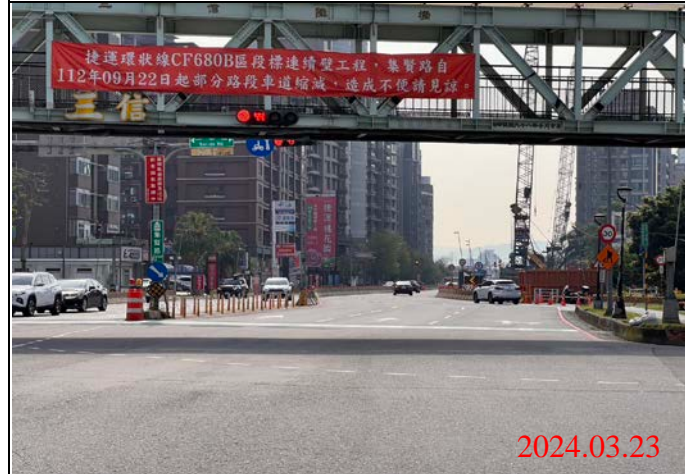
巡查日期地點：113.03.23/ Y23車站 照片說明：路面狀況
