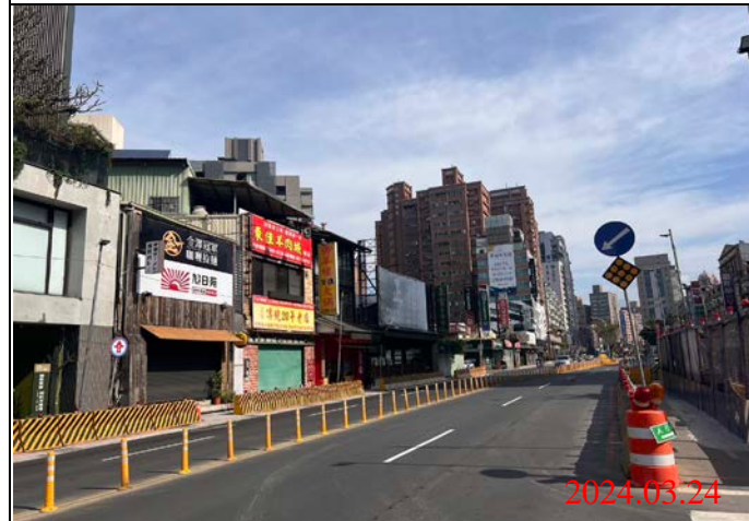
巡查日期地點：113.03.24/ Y21車站 照片說明：路面狀況
