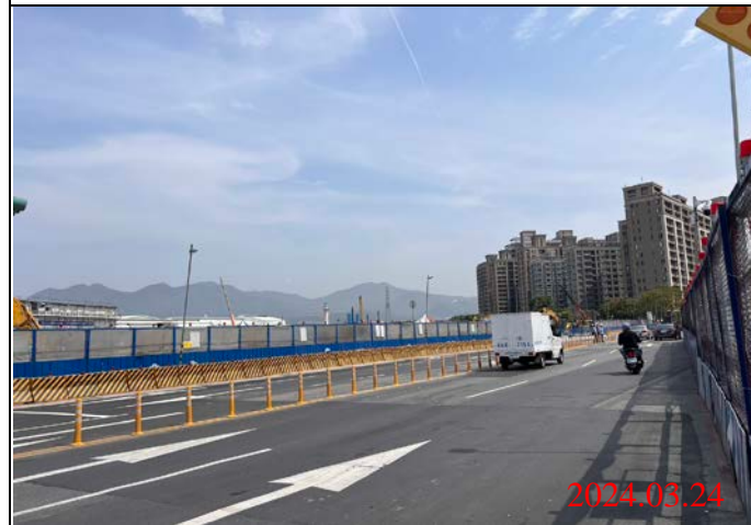
巡查日期地點：113.03.24/ Y22車站 照片說明：路面狀況
