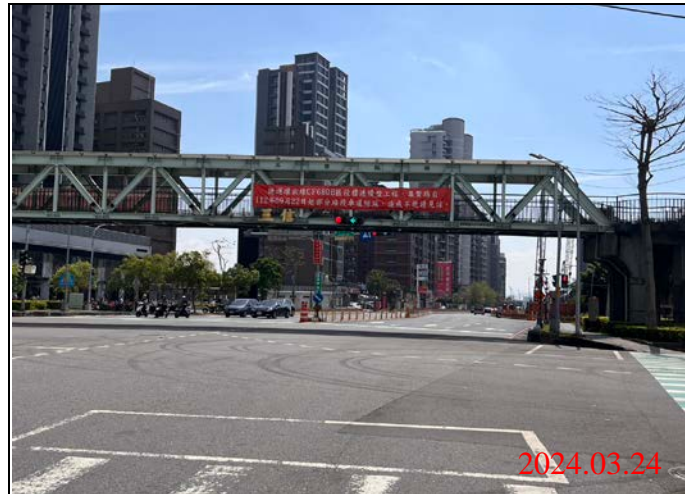
巡查日期地點：113.03.24/ Y23車站 照片說明：路面狀況
