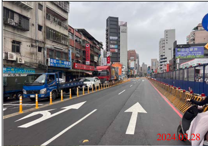
巡查日期地點：113.03.28/ Y21車站 照片說明：路面狀況
