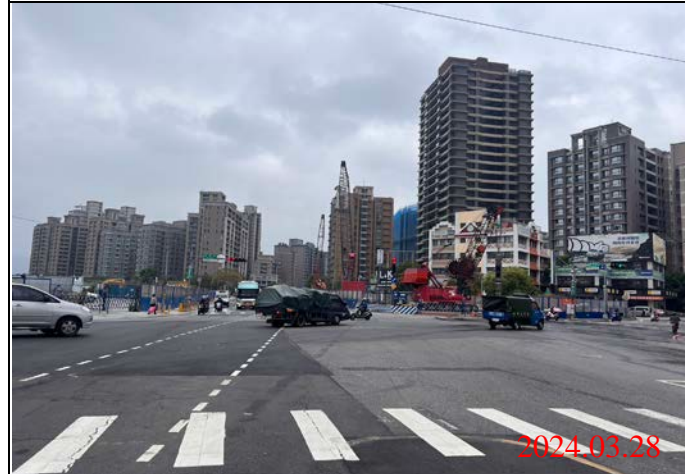
巡查日期地點：113.03.28/ Y22車站 照片說明：路面狀況
