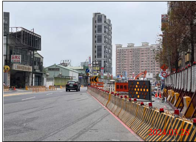
巡查日期地點：113.03.28/ Y22車站 照片說明：路面狀況
